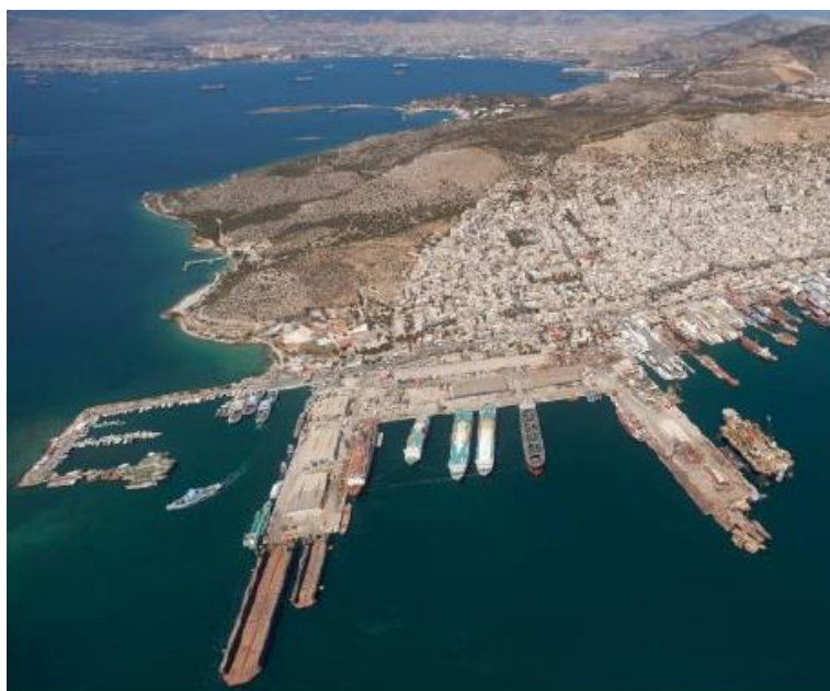
Εικόνα 34: Άποψη περιοχής της ναυπηγοεπισκευαστικής ζώνης. [Πηγή:ΟΛΠ]
