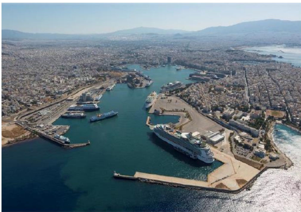
Εικόνα 29: Αποψη της υφιστάμενης κατάστασης στην περιοχή κρουαζιέρας. [Πηγή: ΟΛΠ]
