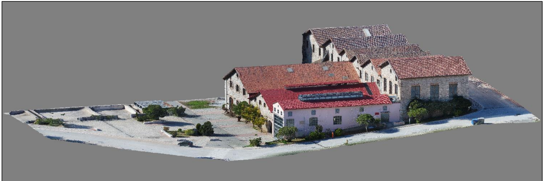
Εικόνα 3.25: Ανατολική όψη της περιοχής
