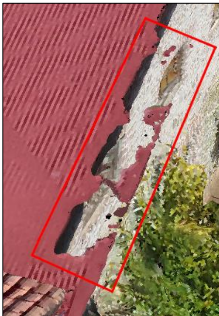
Εικόνα 3.34: Παραμορφώσεις σε στέγη
