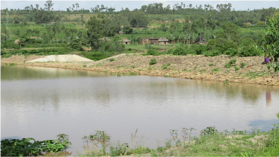
Εικόνα 4.1 Ανάντη πρανές του φράγματος
