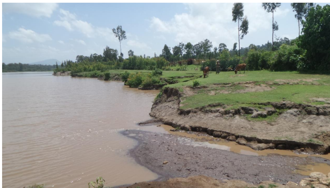
Εικόνα 5.3 Αριστερό Αντέρεισμα - Εδαφικό υλικό που έχει καταλήξει στον ταμιευτήρα
