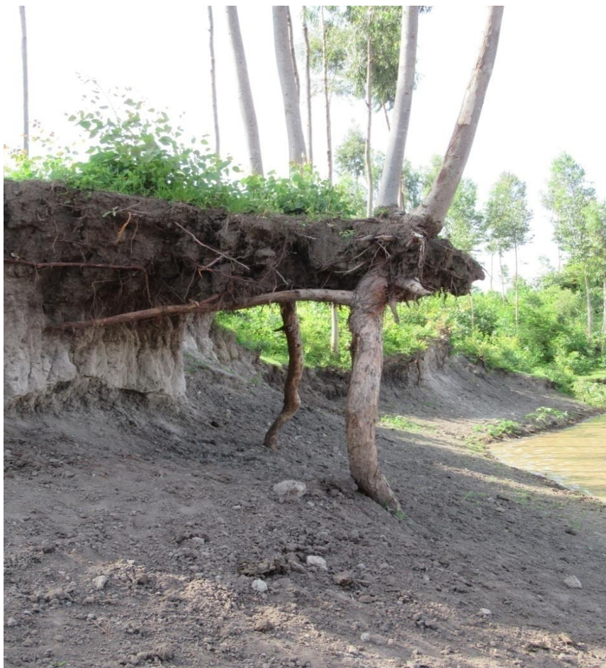
Εικόνα 5.4 Υποσκαφή εδαφικού πρανούς και συγκράτηση εδάφους μέσω του ριζικού συστήματος δέντρου
