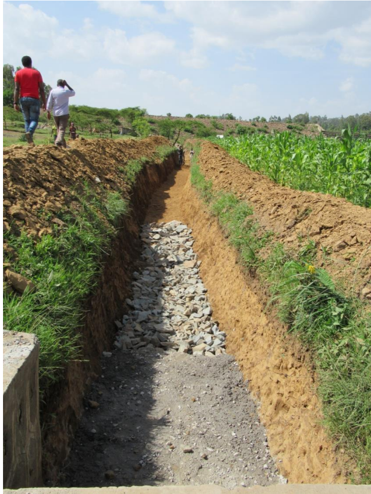
Εικόνα 4.6 Ανακατασκευή κύριου αρδευτικού καναλιού
