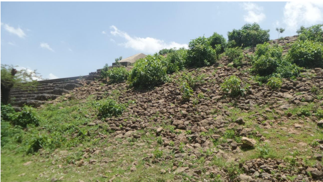
Εικόνα 4.2 Κατάντη πρανές του φράγματος
