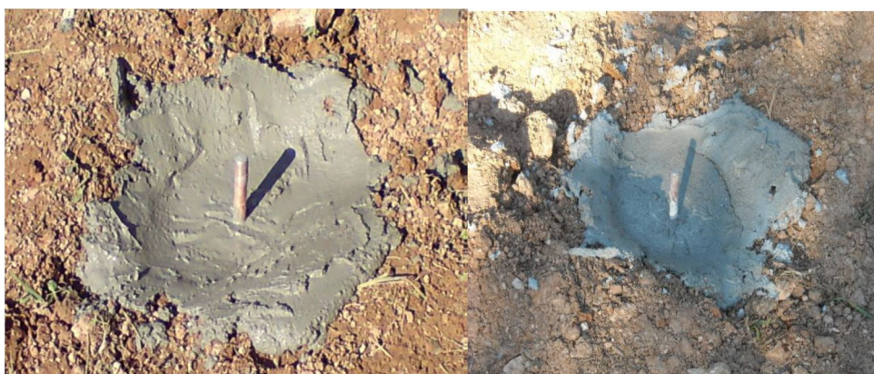
Εικόνα 4.5: Ηλεκτρόδια γείωσης εμβαπτισμένα σε μπεντονίτη και σκυρόδεμα [2].
