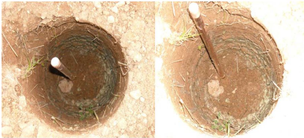
Εικόνα 4.3: Τοποθέτηση ηλεκτροδίων[1].
