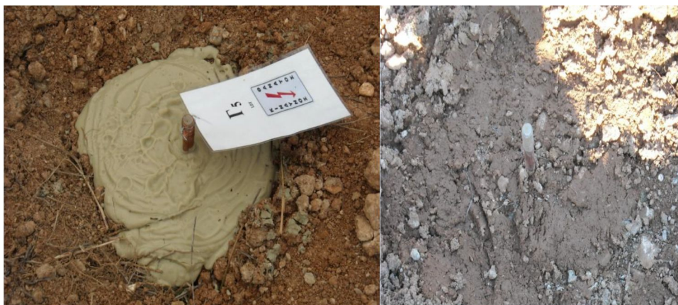
Εικόνα 4.4: Ηλεκτρόδια γείωσης εμβαπτισμένα σε βελτιωτικά υλικά γείωσης [2].
