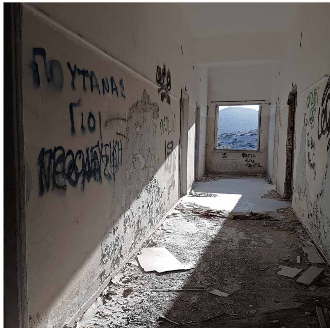
άποψη από διάδρομο του τρίτου ορόφου | δεύτερη φάση κατασκευής
