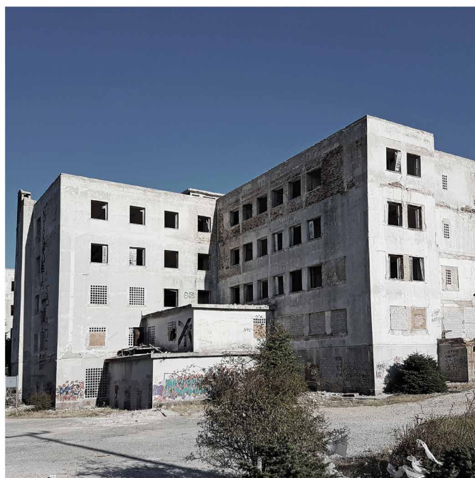
άποψη από τη νοτιοδυτική πλευρά του κτιρίου
