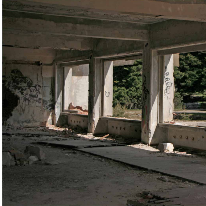
άποψη από το εσωτερικό του κτιρίου | προσθήκη ΕΟΤ
