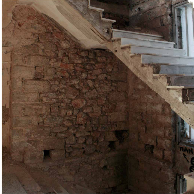
άποψη από κλιμακοστάσιο | πρώτη φάση κατασκευής
