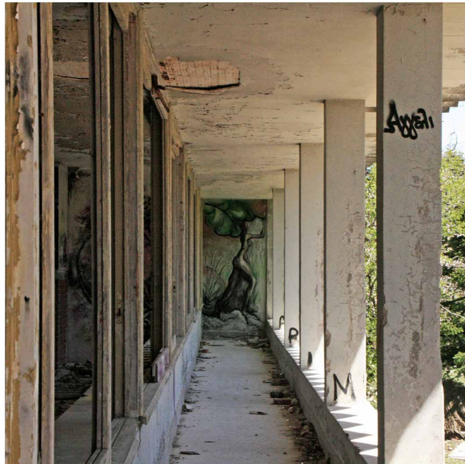
άποψη από το εξωτερικό στέγαστρο | προσθήκη ΕΟΤ
