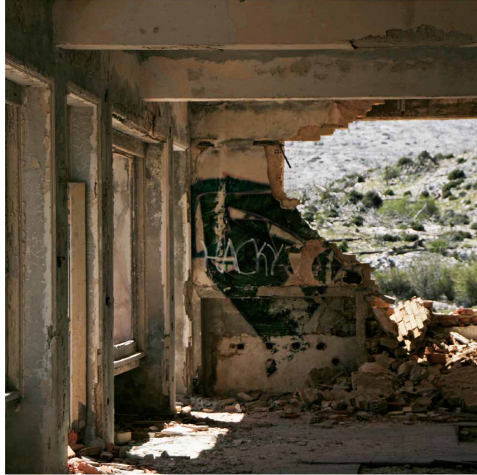
άποψη από το εσωτερικό του κτιρίου | τέταρτη φάση κατασκευής
