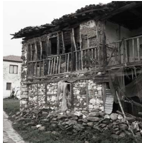
ΕΠΙΣΚΕΨΗ ΠΑΡΑΔΟΣΙΑΚΩΝ ΟΙΚΙΣΜΩΝ
