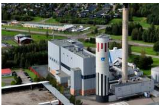
Εικόνα 12: Θερμοηλεκτρικός Σταθμός Fjärrvarmeverket, Backelund
