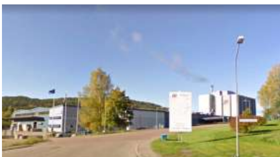
Εικόνα 14: θερμοηλεκτρικός Σταθμός Amotsfors Energi
