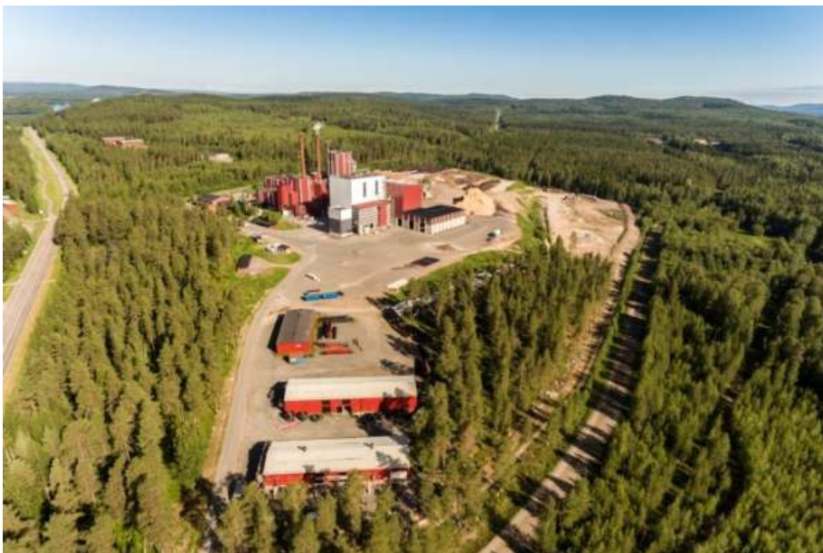
Εικόνα 11: θερμοηλεκτρικός Σταθμός Bodens Varmeverk Energi
