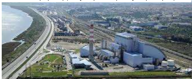
Εικόνα 8: Μονάδα Αποτέφρωσης Αποβλήτων με Ανάκτηση Ενέργειας στην Λισαβόνας στην Πορτογαλία
