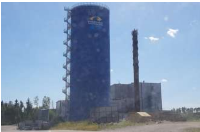
Εικόνα 16: σταθμός θερμικής ενέργειας «FTV Varmeverket»
