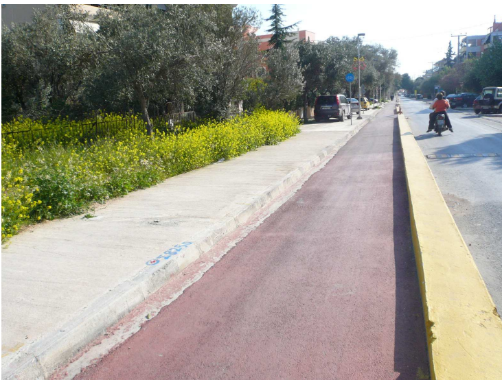
Εικόνα 3.5 – Αμφίδρομη λωρίδα κυκλοφορίας ποδηλάτου με μικρά διαχωριστικά από το οδόστρωμα, Jerez, Spain
