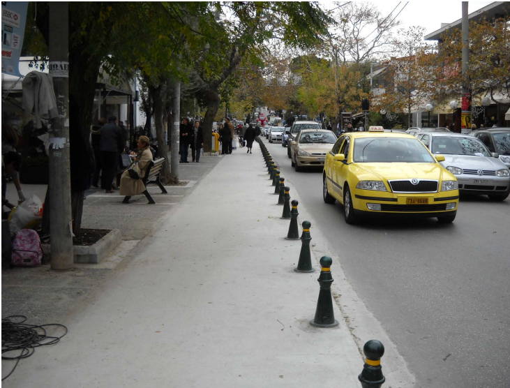
Εικόνα 3.4 – Διαπλάτνση πεζοδρομίου, Κηφισιά, Πηγή 'Θάνος Βλαστός'
