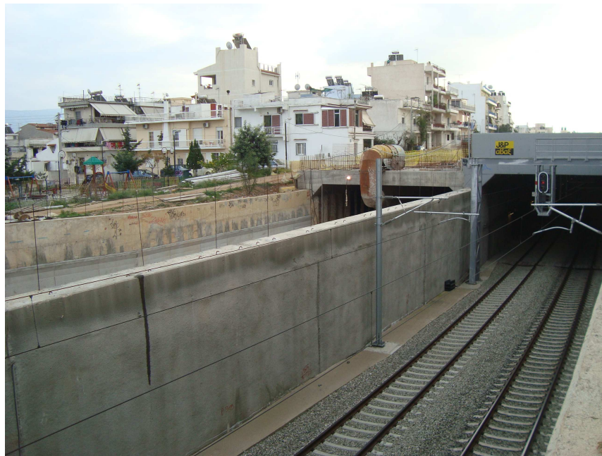
Εικόνα 4.15 – Η βόρεια πλευρά έναρξης της υπογειοποίησης των γραμμών. «Πύργος Βασιλίσσης»
