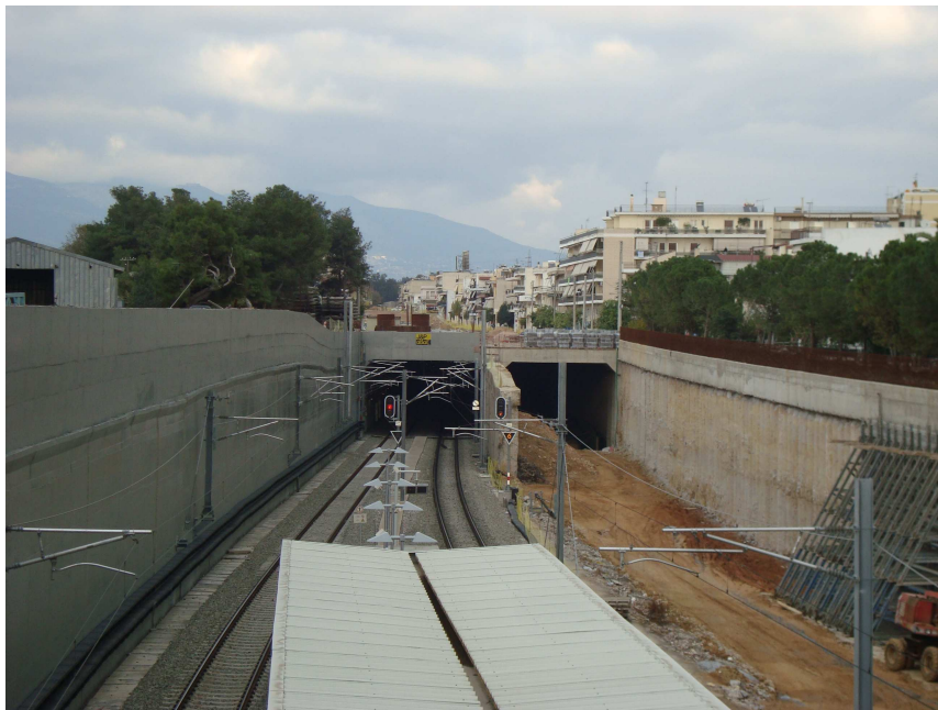
Εικόνα 4.17 – Η νότια πλευρά της υπογειοποίησης. Σταθμός «Άγιοι Ανάργυροι»
