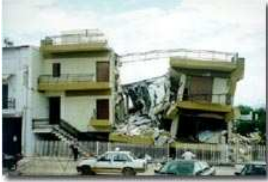
Εικόνα 1.4 – Υλικές ζημιές μετά από σεισμικό συμβάν
