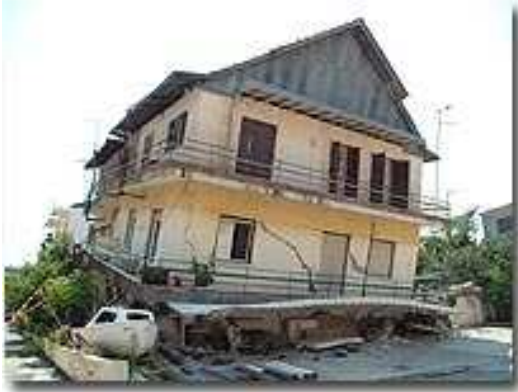
Εικόνα 1.2 – Χαρακτηριστική εικόνα κατάρρευσης κτιρίου λόγω σεισμού
