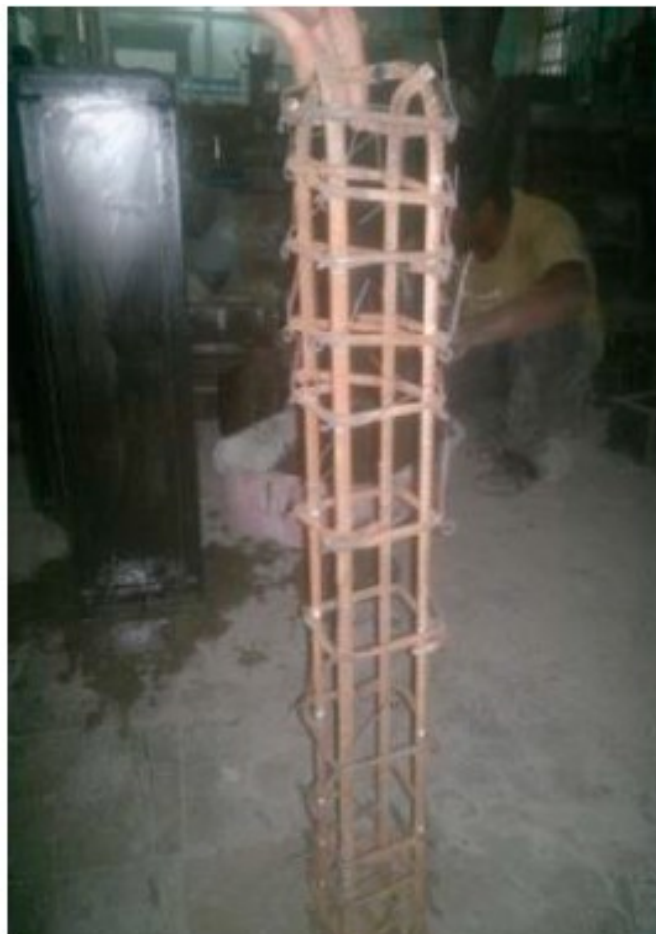
Εικόνα 1: Σκελετός r/f στύλου Τύπου I
