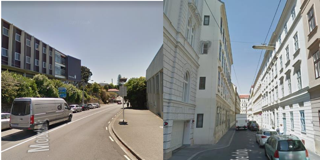
Εικόνα 66: Τμήμα του οδικού δικτύου του Auckland (αριστερά) & της Βιέννης (δεξιά) Πηγή: Google Street View
