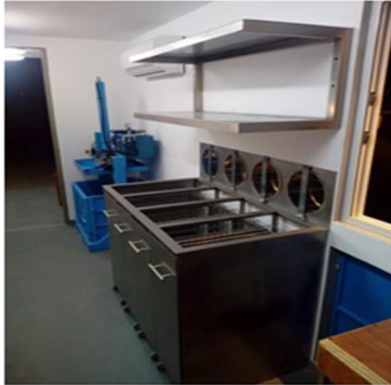
Εικόνα 8. Ειδικόί κάδοι buffer για την παραλαβή των 4 κύριων εισερχόμενων ρευμάτων υλικών – χαρτί, γυαλί, πλαστικό, μέταλλο. (Πηγή: PAVEtheWAYSTE ε , Παραδοτέο B2.3)
