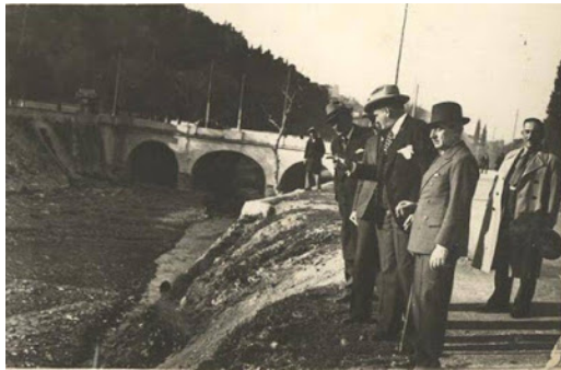
Σχήμα 5.24: Ο Διοικητής Πρωτεύουσας (επί δικτατορίας Μεταξά) Κωνσταντίνος Κοτζιάς επισκέπτεται τα έργα της κάλυψης Ιλισσού. Στο βάθος φαίνεται η μαρμάρινη τρίτοξη γέφυρα. (Φωτ. 1937)
