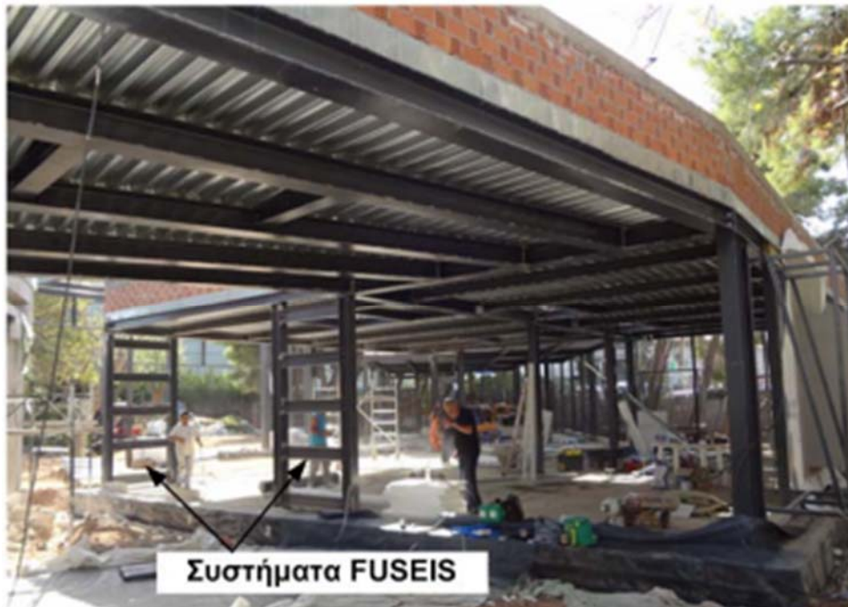
Σχήμα 5-1: Εφαρμογή συστημάτων Fuseis σε σύμμικτο κτίριο
