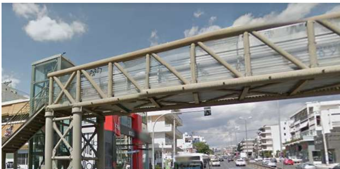
Εικόνα 10-2: Δικτυωτή πεζογέφυρα στην λεωφόρο Κηφισίας στο ύψος του Αμαρουσίου
