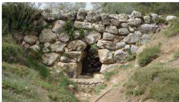
Εικόνα 1-1: Γέφυρα του Αρκαδικού
