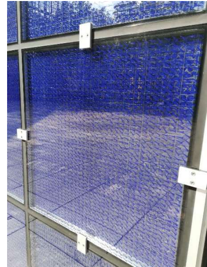
Εικόνα 1.2: Λεπτομέρεια Πρόσοψης Figure 1.2: Façade detail
