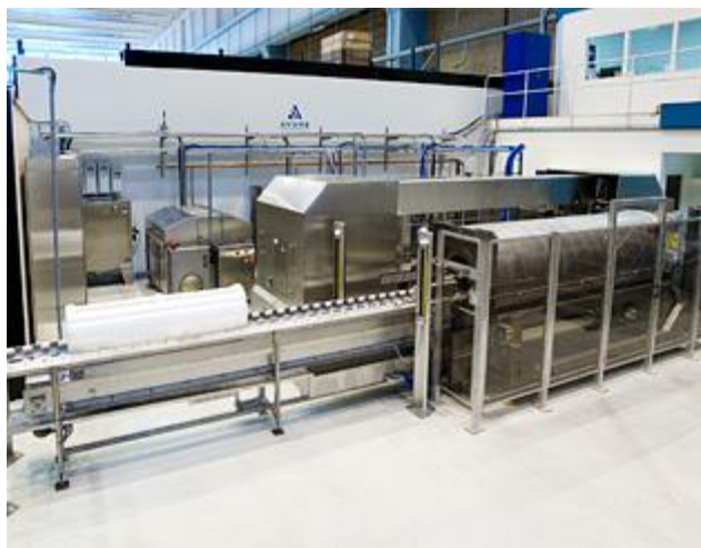
Εικόνα 3.4. Εγκατάσταση Υπερυψηλής Πίεσης σε εργοστασιακή μονάδα
