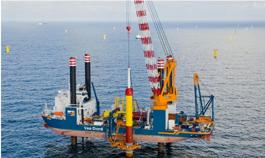
Εικόνα 4-3: Εγκατάσταση πασσάλου με υδραυλική σφύρα
