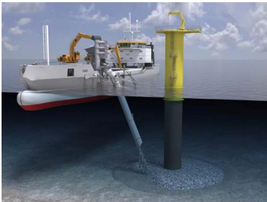
Εικόνα 4-7: Εφαρμογή προστασίας έναντι υποσκαφής μετά την εγκατάσταση του πασσάλου [24]
