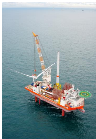
Εικόνα 4-4: Εγκατάσταση ανεμογεννήτριας [25]
