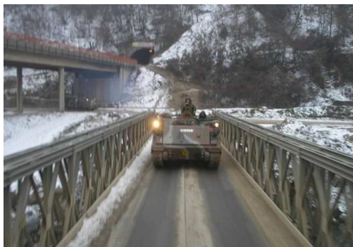
Εικόνα 1.1 Κίνηση ερπυστριοφόρου οχήματος επί γέφυρας Μπέλεϊ Μ2
