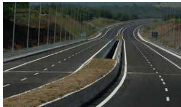
Εικόνα 2.3 Οδός Διπλής Κατεύθυνσης και Διπλής Κυκλοφορίας
