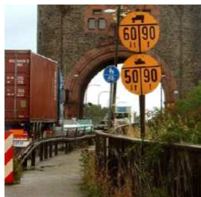
Εικόνα 2.6 Πινακίδες Κλασικοποίησης της Nibelungen Bridge Worms Germany
