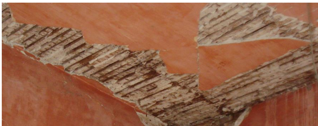
Εικόνα 3.22 Οροφή Β' στάθμης όπου έχει αποκαλυφθεί το οροφοκονίαμα.
