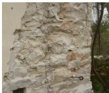
Εικόνα 3.9 Δόμηση τοιχοποιίας στις γωνίες του κτιρίου.
