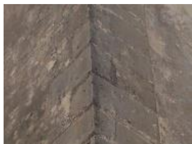
Εικόνα 3.10 Γωνιακοί λίθοι στο εξωτερικό του κτιρίου.
