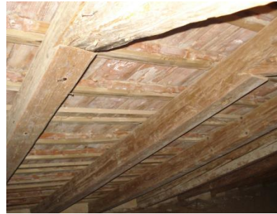
Εικόνα 3.19 Σύνδεση οριζόντιου ελκυστήρα με αμείβοντες.
