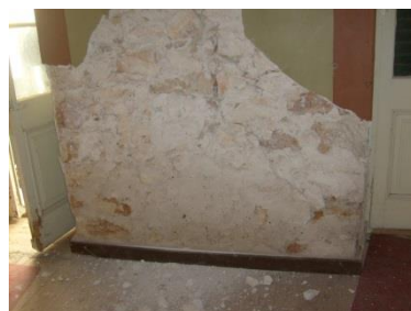
Εικόνα 3.11 Ποιότητα τοιχοποιίας στο εσωτερικό του κτιρίου.
