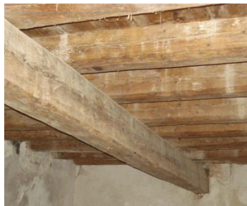
Εικόνα 3.25 Κύρια δοκός δαπέδου Β' στάθμης, που εισέρχεται εντός της φέρουσας τοιχοποιίας.
