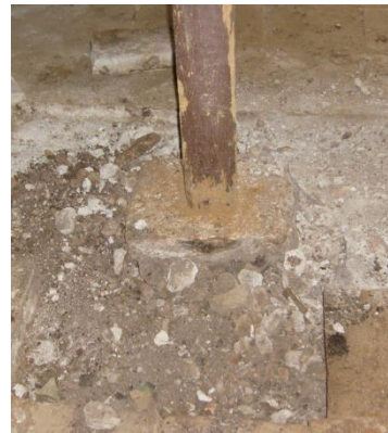
Εικόνα 3.31 Θεμελίωση ξύλινου υποστυλώματος με μικρό λίθινο πέδιλο.
