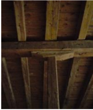
Εικόνα 3.27 Ξύλινο υποστύλωμα στο οποίο στηρίζεται η κύρια δοκός.
