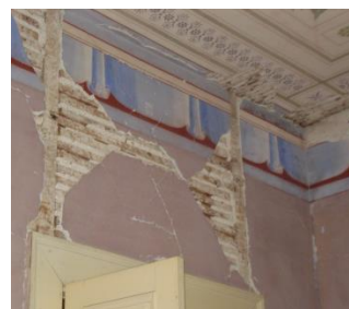
Εικόνα 3.12 Εσωτερική ξυλόπηκτη τοιχοποιία.
