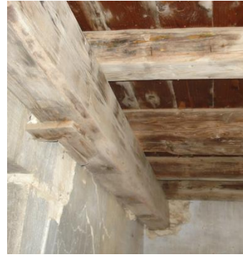
Εικόνα 3.28 Ξύλινη κύρια δοκός παράλληλη με τη φέρουσα λιθοδομή πάνω στην οποία στηρίζονται οι διαδοκίδες του δαπέδου της προσθήκης.
