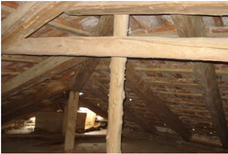
Εικόνα 3.18 Ξύλινοι ορθοστάτες που τοποθετούνται στα τριγωνικά τμήματα της στέγης, πρόχειρα στερεωμένοι.
