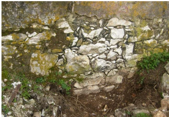
Εικόνα 3.30 Ανάδειξη θεμελίωσης φέρουσας λιθοδομής.
