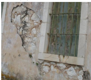
Εικόνα 3.8 Μορφή αργολιθοδομής με την οποία έχει δομηθεί η φέρουσα τοιχοποιία.
