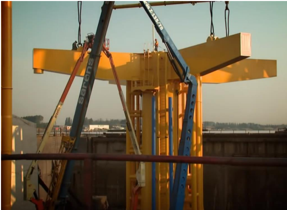
Σχήμα 2.15: Ανέγερση του κομματιού προσαρμογής.
