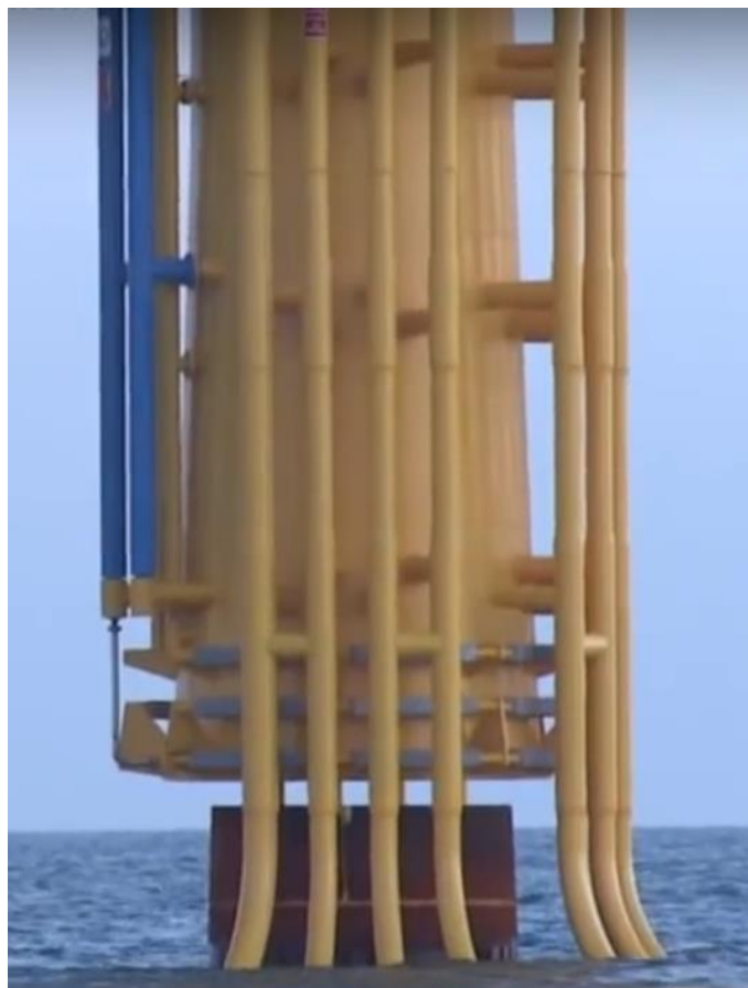
Σχήμα 2.16: Σύνδεση μεταξύ του πασσάλου και του κομματιού προσαρμογής.
