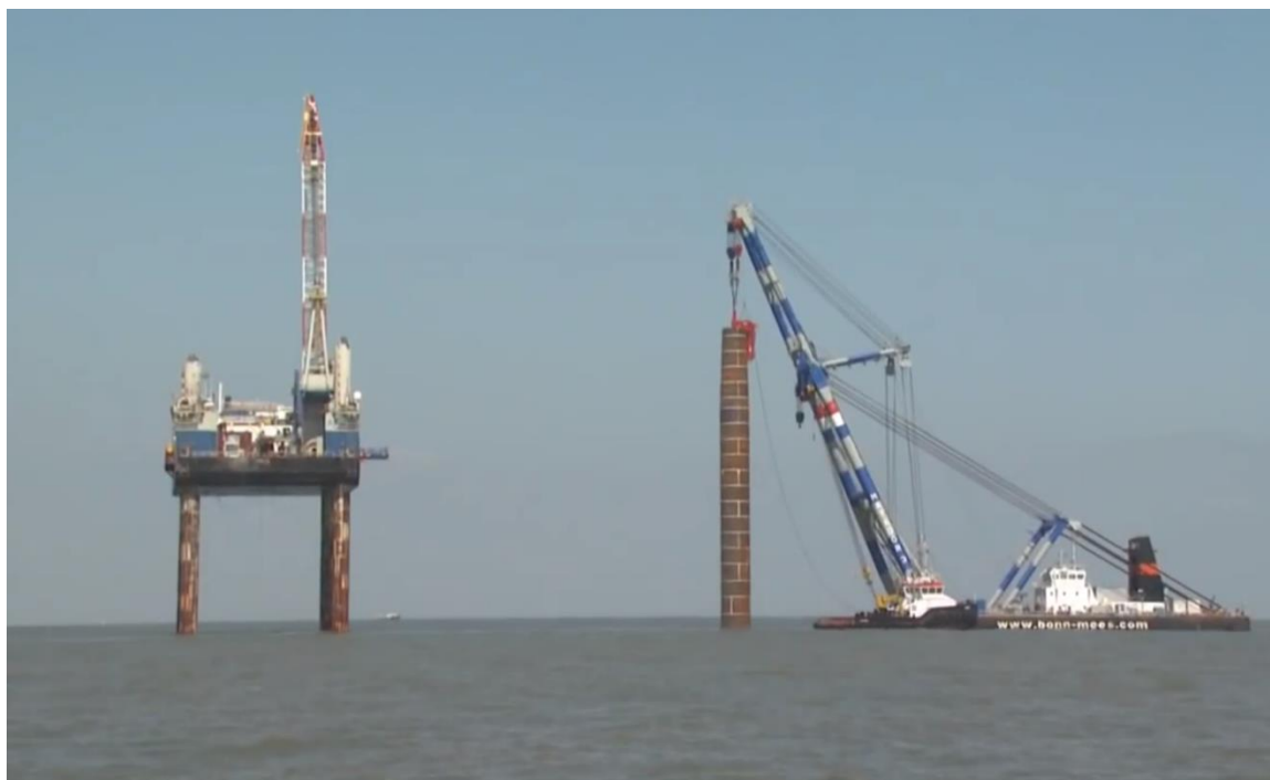
Σχήμα 2.13: Ανέγερση και τοποθέτηση του πασσάλου.
