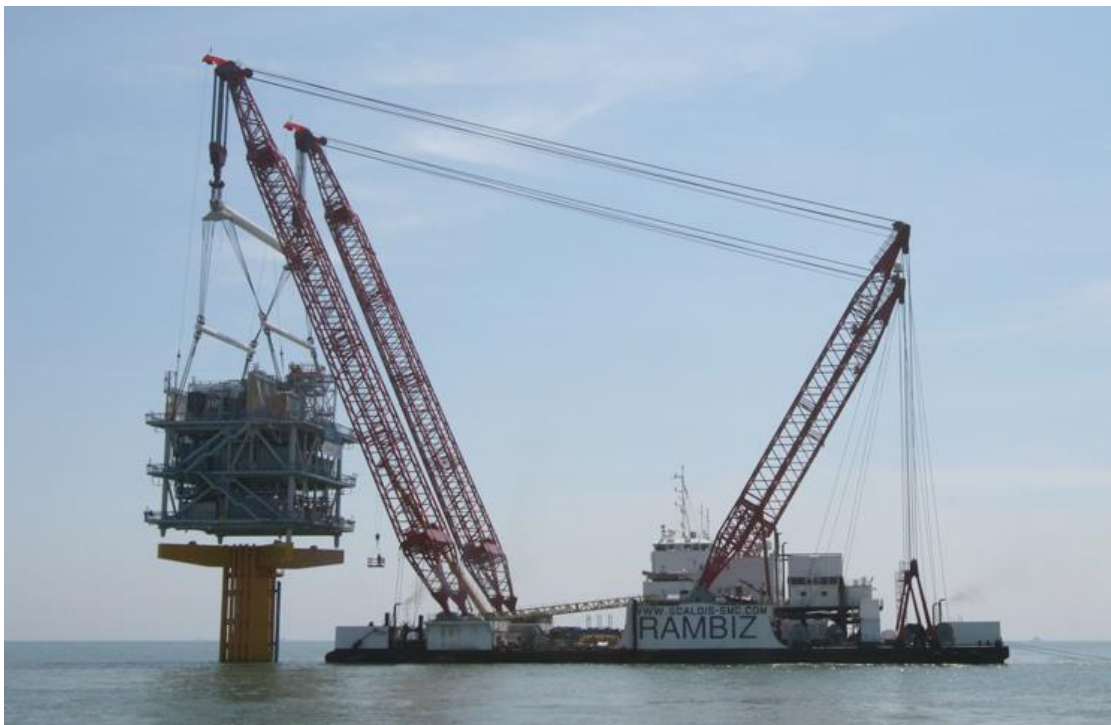
Σχήμα 2.18: Τοποθέτηση του υποσταθμού στην τελική του θέση.
