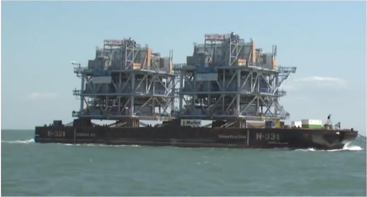
Σχήμα 2.17: Μεταφορά του υποσταθμού στη θέση του έργου.
