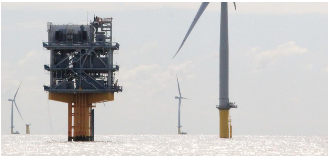
Σχήμα 2.1: Υποσταθμός του πάρκου London Array
