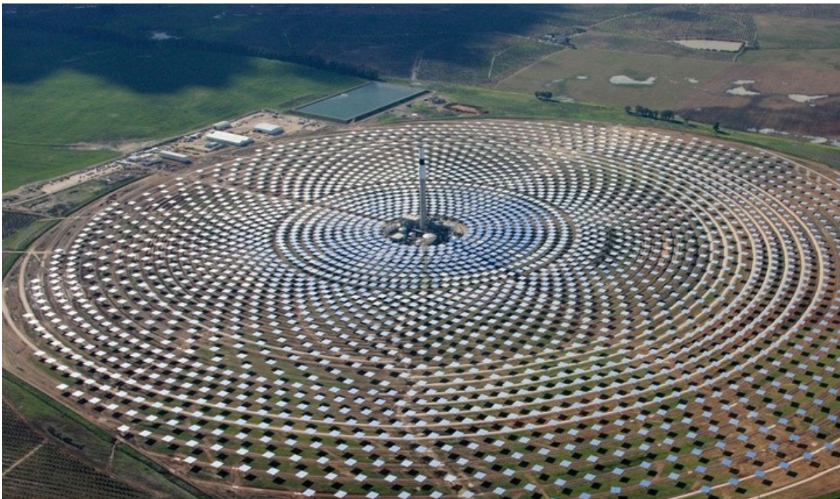
Εικόνα 8. Εγκατάσταση Ηλιακού Πύργου Ισχύος Gemasolar στην Ισπανία.
