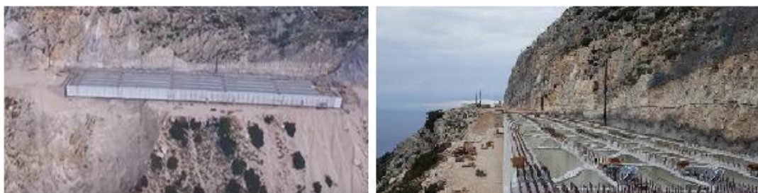
Σχήμα 1.10: Η γέφυρα του Χάρακα στην Κεφαλονιά σε φάση κατασκευής.
