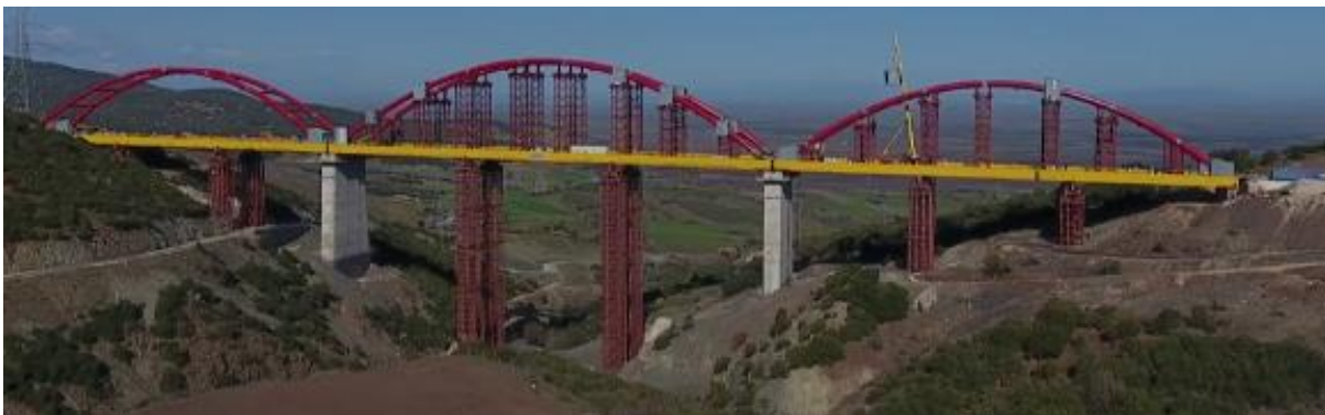
Σχήμα 1.12: Γενική άποψη της γέφυρας της Εκκάρρας στην φάση κατασκευής.
