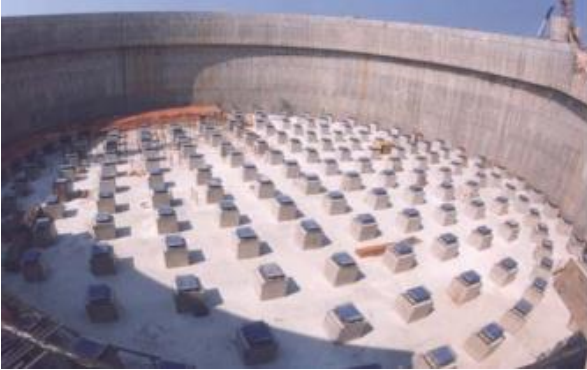
Σχήμα 1.7: Η σεισμική μόνωση των δεξαμενών της Ρεβυθούσας.
