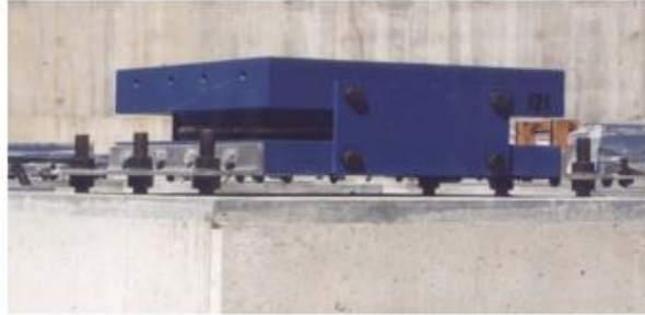
Σχήμα 1.7: Η σεισμική μόνωση των δεξαμενών της Ρεβυθούσας.
