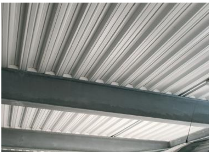
Σχήμα 4.1: Τυπική διάταξη υποδομής σύμμικτης πλάκας
