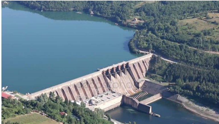
Εικόνα 1.4: Υδροηλεκτρικό εργοστάσιο στον ποταμό Ντρίνα
