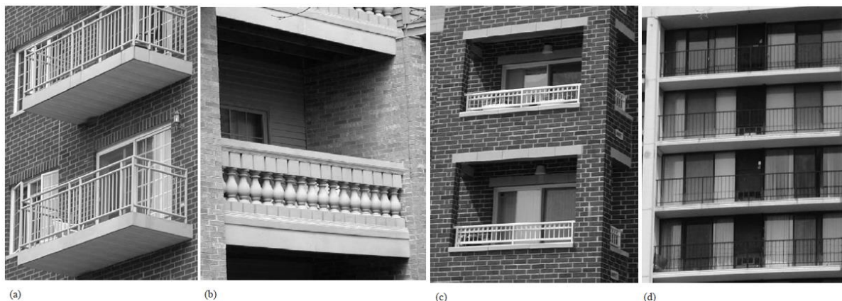
Σχήμα 2.25 Τύποι μπαλκονιών από αριστερά προς τα δεξιά: (a) Τύπος I, (b) Τύπος II, (c) Τύπος III, (d) Τύπος IV (Mammoser and Battaglia, 2003)
