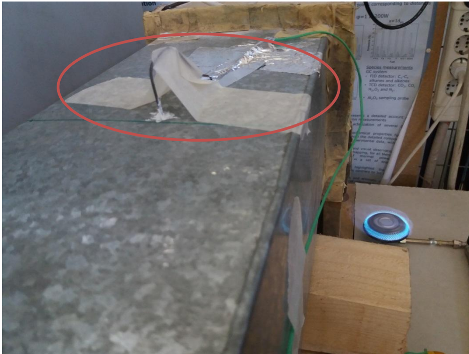
Σχήμα 5.10 Θερμοστοιχείο τοποθετημένο πλησίον της εισόδου του πρωτεύοντος αγωγού
