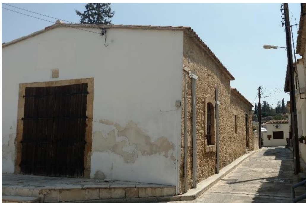
Εικόνα 11 Μορφή Κτηρίου εξωτερικά (δυτική όψη)
