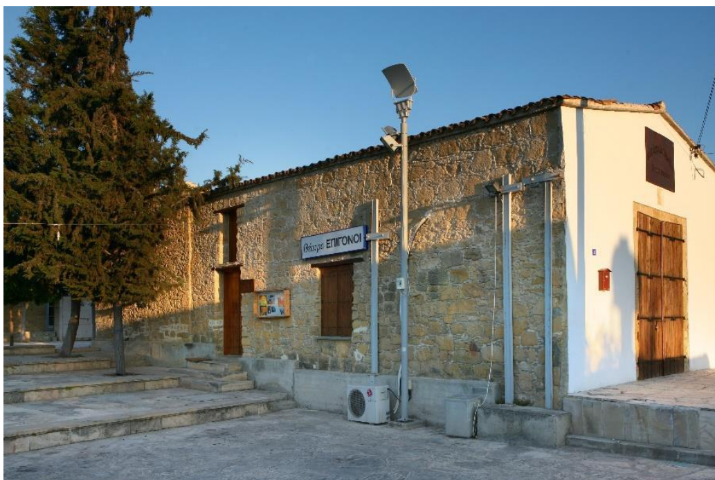
Εικόνα 10 Μορφή Κτηρίου εξωτερικά (Ανατολική όψη)
