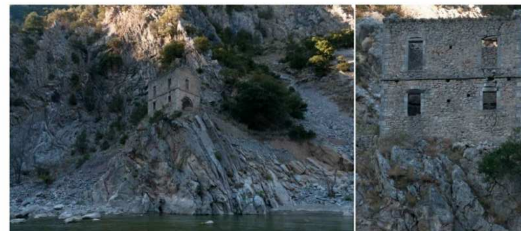
Εικόνα 2.5 Κτήριο Τελωνείου – Βορειοανατολικό (Πλευρά Καρδίτσας)
