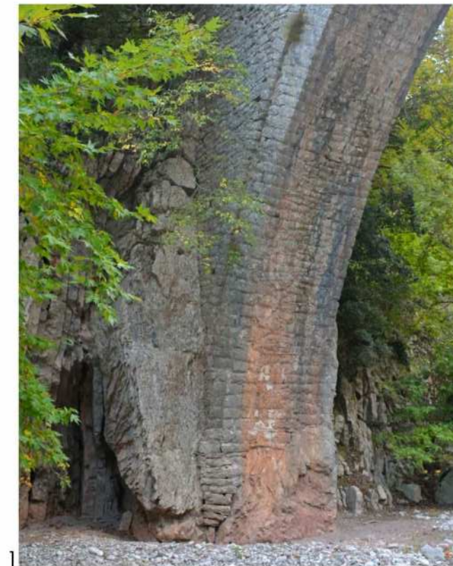
Εικόνα 4.16 Έδραση σε βράχο και λεπτομέρεια τόξου γέφυρας Τριζώλου (Χρήστος Γιαννέλος)
