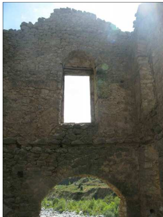
ΦΩΤΟΓΡΑΦΙΑ 3 ΕΣΩΤΕΡΙΚΗ ΑΝΑΤΟΛΙΚΗ ΟΨΗ
