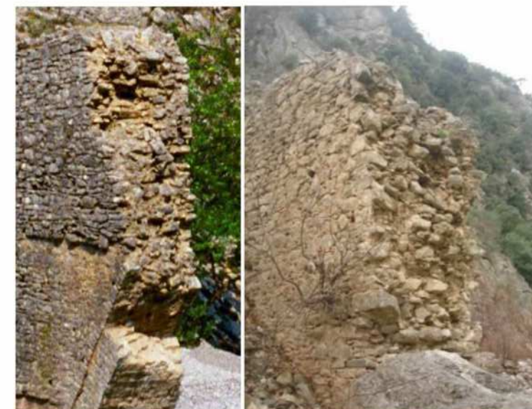
Εικόνα 4.4 Άποψη γεμίσματος ΒΑ και ΝΔ βάθρου
