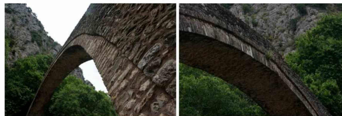
Εικόνα 4.18 Όψη από κανάντη του τόξου και άποψη του τόξου στην περιοχή του κλειδώματος, 2018
