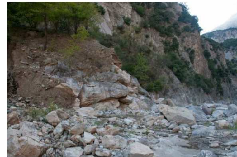
Εικόνα 6.3 Νοτιοδυτικό ακρόβαθρο γέφυρας, έδραση επί ασβεστόλιθου.
