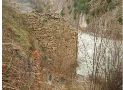
Εικόνα 3.23 ΝΔ βάθρο εις 2015, όψη από κατάντη
