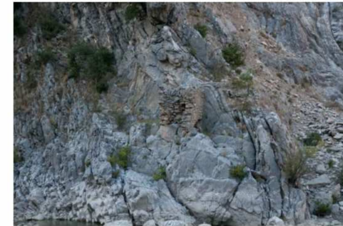
Εικόνα 6.2 Βορειοανατολικό ακρόβαθρο γέφυρας, έδραση επί ασβεστόλιθου χαρακτηριστικά ανορθωμένου.
