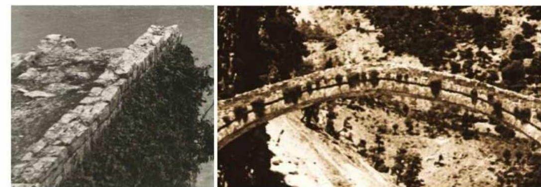
Εικόνα 4.6 ΝΔ βάθρο, αρχή καταστρώματος και στηθαίο. Ανάπτυξη βλάστησης στο κεντρικό τμήμα
