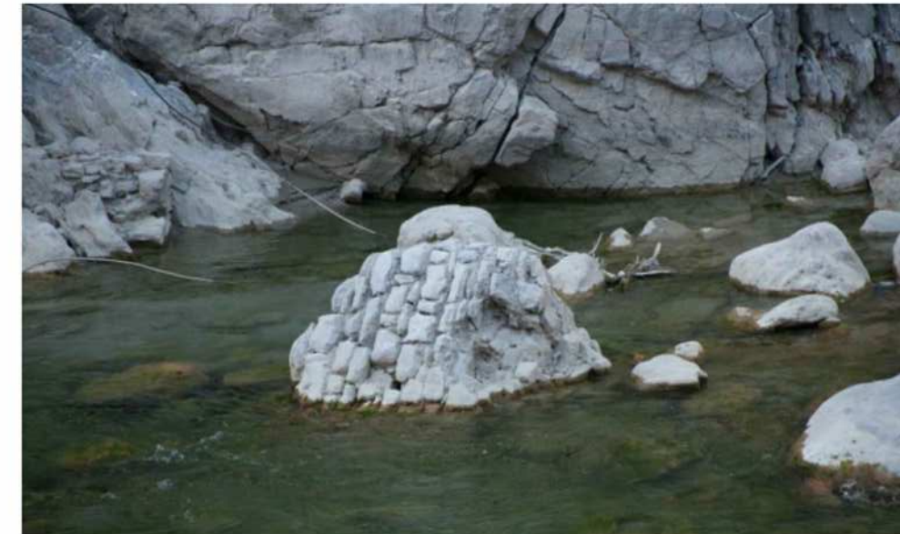
Εικόνα 2.4 Τμήμα της γέφυρας εντός της κοίτης
