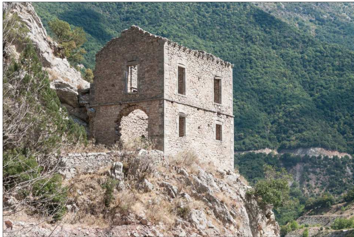
ΦΩΤΟΓΡΑΦΙΑ 2 ΝΟΤΙΑ ΔΥΤΙΚΗ ΟΨΗ
