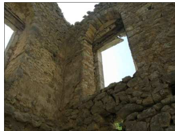
ΦΩΤΟΓΡΑΦΙΑ 4 ΕΣΩΤΕΡΙΚΗ ΝΟΤΙΑ ΟΨΗ
