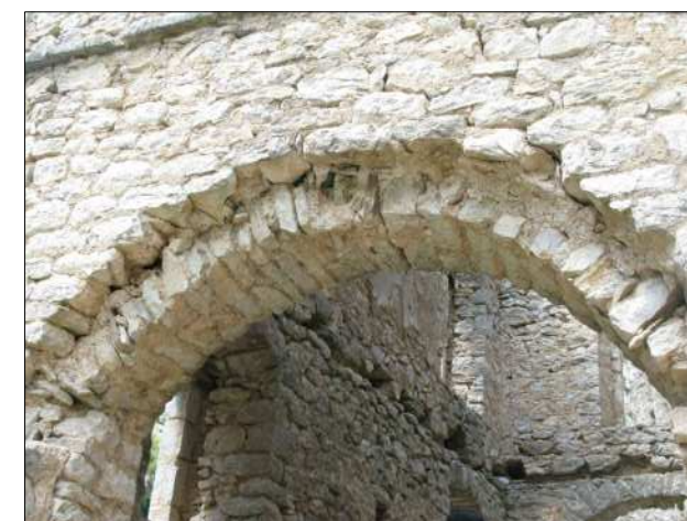
ΦΩΤΟΓΡΑΦΙΑ 12 ΛΕΠΤ. ΑΝΑΤΟΛΙΚΗΣ ΑΨΙΔΑΣ ΕΙΣΟΔΟΥ
