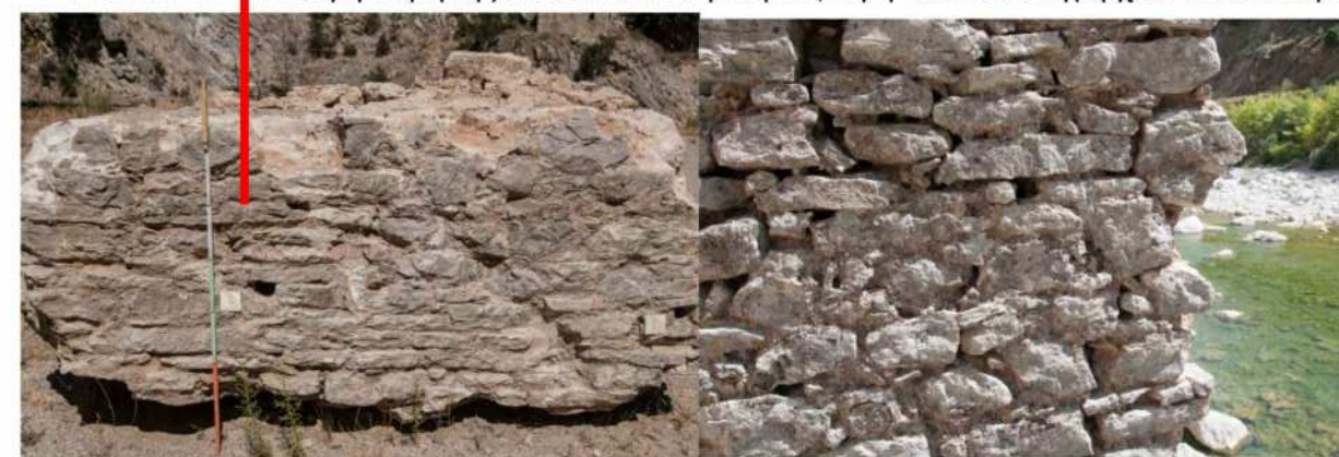
Εικόνα 4.3 Άποψη δόμησης πλευρών ΝΔ και ΒΑ βάθρων( Σημερινές εικόνες, 2017)
