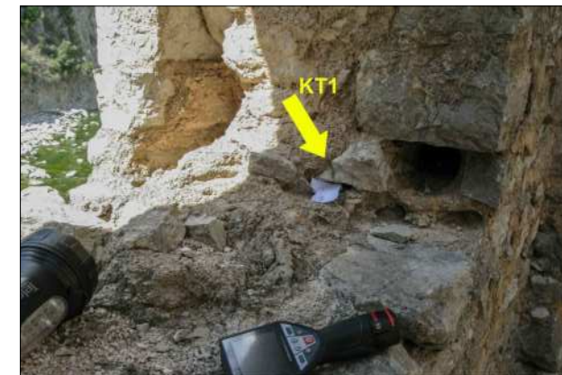
Λήψη δειγμάτων από τον Νότιο τοίχο του κτηρίου τελωνείου.
