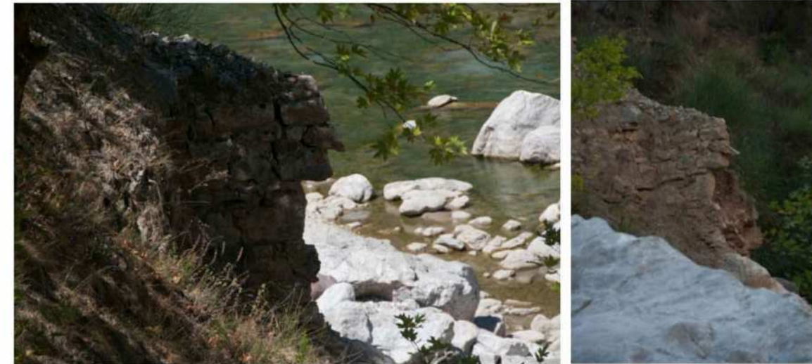
Εικόνα 2.1 Τμήμα Νοτιοδυτικού Βάθρου ( Πλευρά Άρτας)
