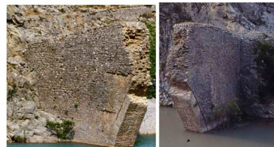
Εικόνα 4.5 : Βορειοανατολικό βάθρο ανάντη και κατάντη
