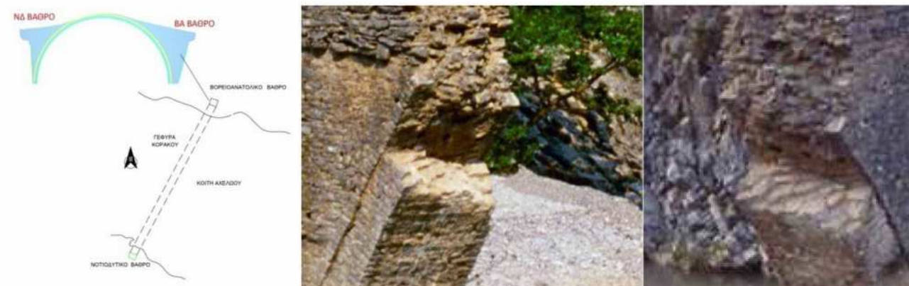
Εικόνα 4.1 Σκαρίφημα θέσεως βάθρων, απόψεις δόμησης κυρίως τόξου και περιμετρικής δόμησης δευτερεύοντος επάλληλου – τομές ΒΑ βάθρου
