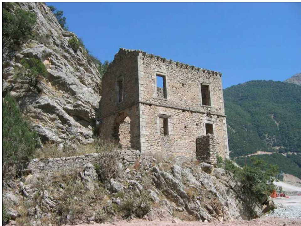
ΦΩΤΟΓΡΑΦΙΑ 10 – ΠΕΤΡΙΝΟΣ ΤΟΙΧΟΣ ΑΝΤΙΣΤΗΡΙΞΗΣ ΠΕΡΙΜΕΤΡΙΚΕΣ ΕΠΙΧΩΣΕΙΣ ΛΟΓΩ ΤΩΝ ΕΡΓΩΝ ΤΗΣ ΔΕΗ
