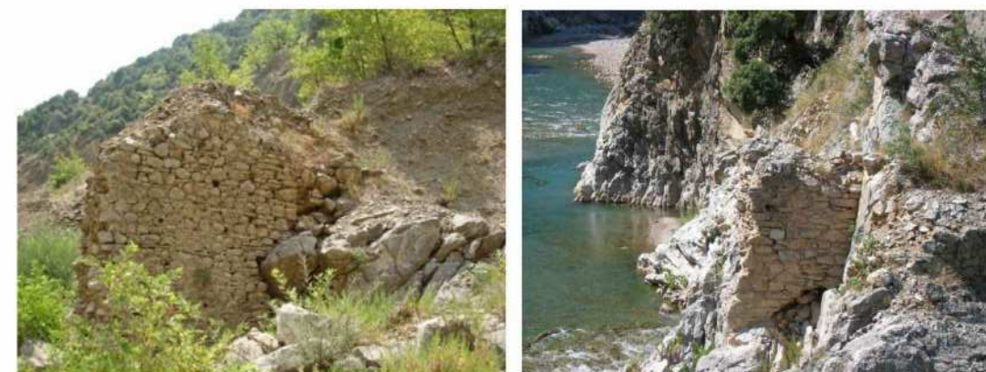
Εικόνα 1.8 Φωτογραφίες εναπομείναντων τμημάτων ΝΔ και ΒΑ βάθρων αρχές 2000-2015, αρχείο Μ.Παπαδημητρίου
