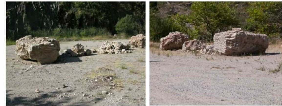
Εικόνα 2.2 Ανασυρθέντα Τμήματα Νοτιοδυτικού Βάθρου
