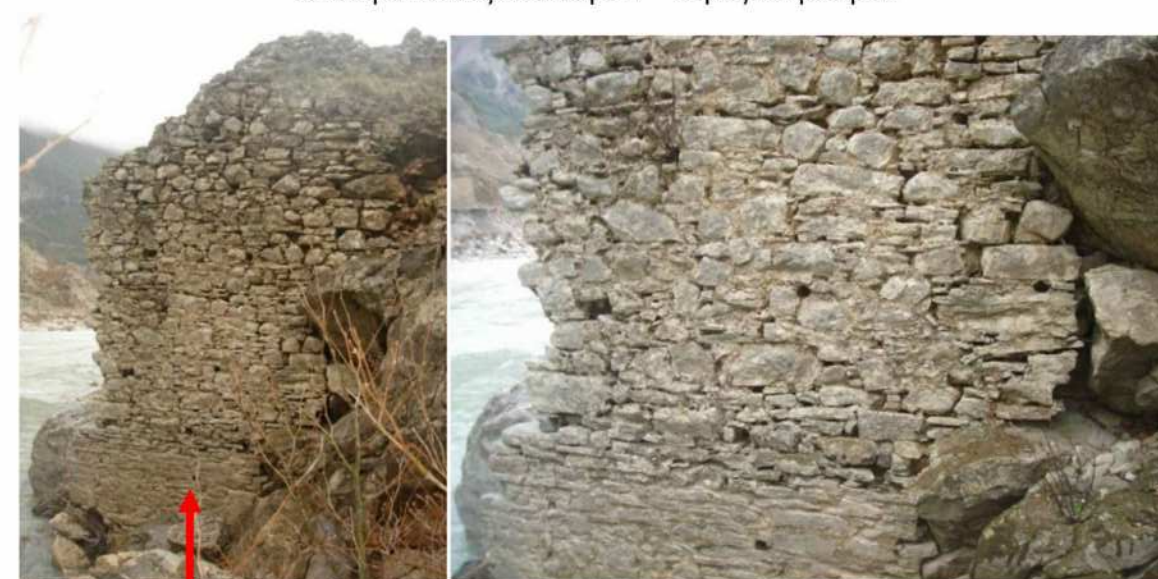
Εικόνα 4.2 Άποψη δόμησης Νοτιοδυτικού βάθρου, όψη από ανάντη(αρχείο κ. Χ.Καπερώνη)
