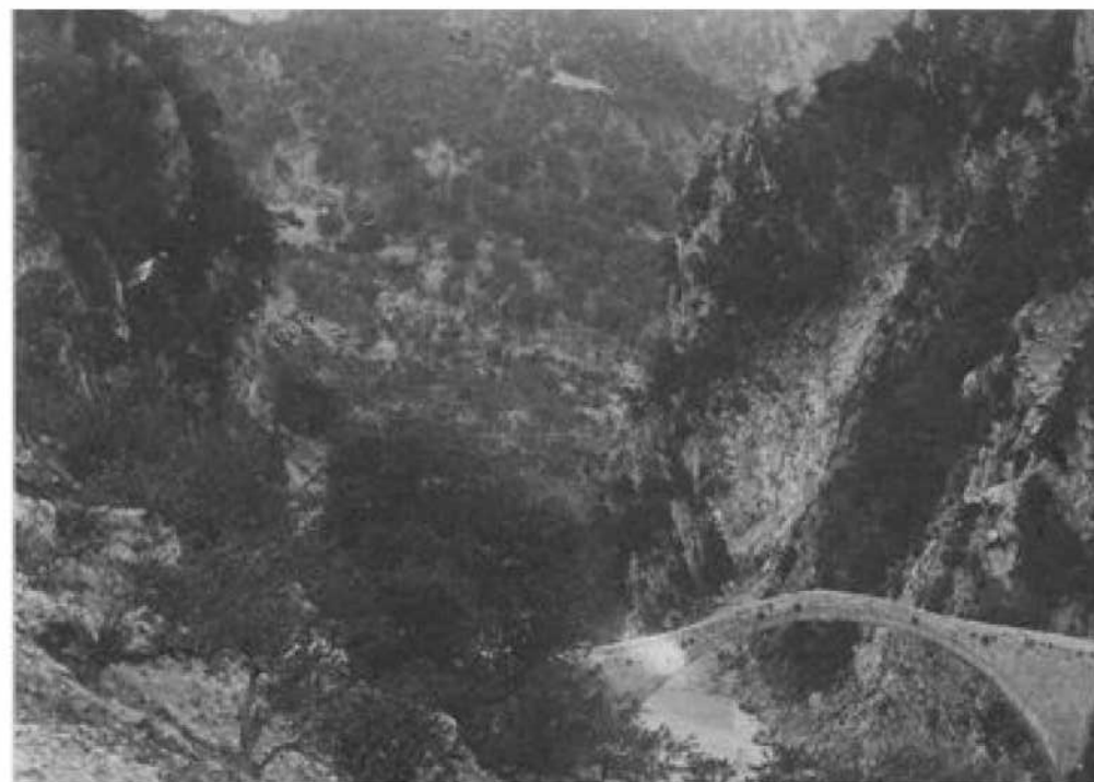
Εικόνα 1.4 Φωτογραφία 1, όψη από κατάντη (Alfred Philippson, 1893)
