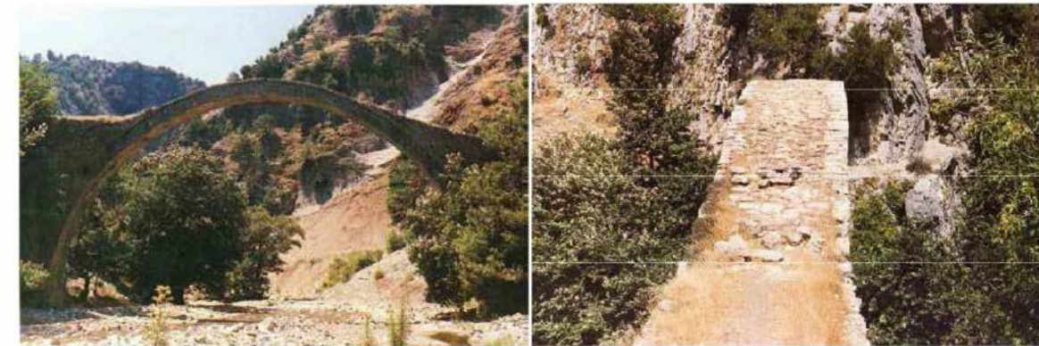
Εικόνα 4.13 Ανάντη όψη και λεπτομέρεια καταστρώματος (Γαλερίδης Α.)
