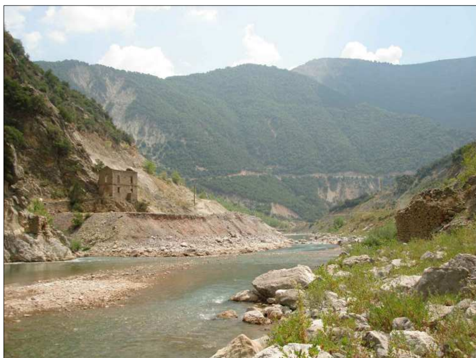
ΦΩΤΟΓΡΑΦΙΑ 11 ΣΥΝΟΛΙΚΗ ΑΠΩΣΗ ΚΤΙΡΙΟΥ ΜΕ ΤΗΝ ΕΠΙΧΩΜΕΝΗ ΠΕΡΙΟΧΗ ΛΟΓΩ ΤΩΝ ΕΡΓΩΝ ΤΗΣ ΔΕΗ.
