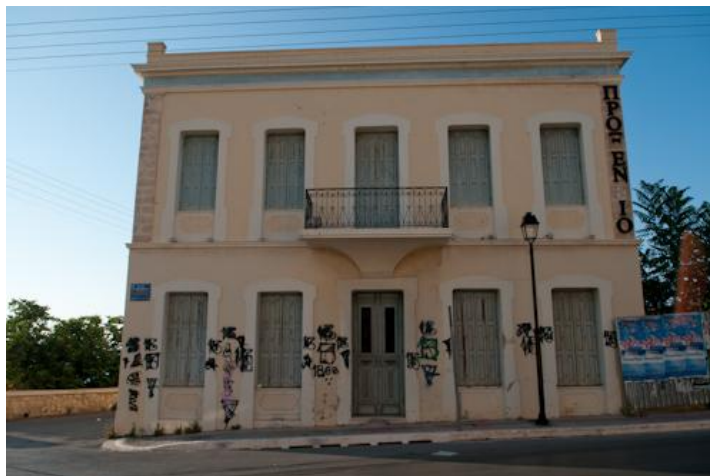
Εικόνα 6. Διατηρητέο κτίριο 10. Πηγή: Ιδία Επεξεργασία
