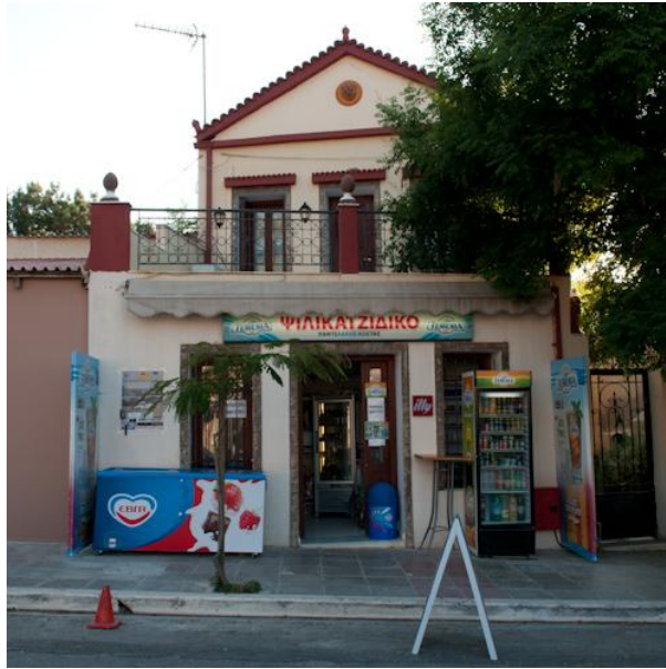
Εικόνα 8. Διατηρητέο κτίριο 12. Πηγή: Ιδία Επεξεργασία
