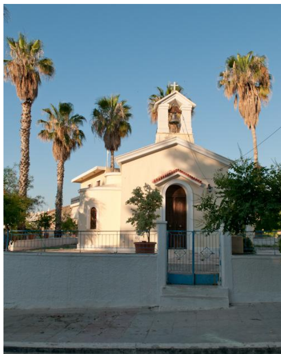
Εικόνα 23. Ι.Ν. Αγίου Γεωργίου, διατηρητέο κτίριο 36. Πηγή: Ιδία Επεξεργασία
