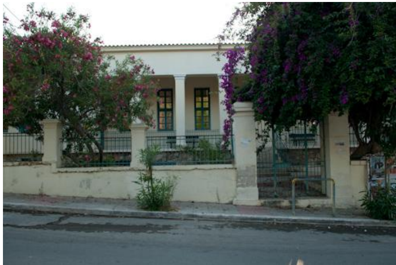
Εικόνα 10. 9 ο Δημοτικό Σχολείο Χανίων, διατηρητέο κτίριο 14. Πηγή: Ιδία Επεξεργασία
