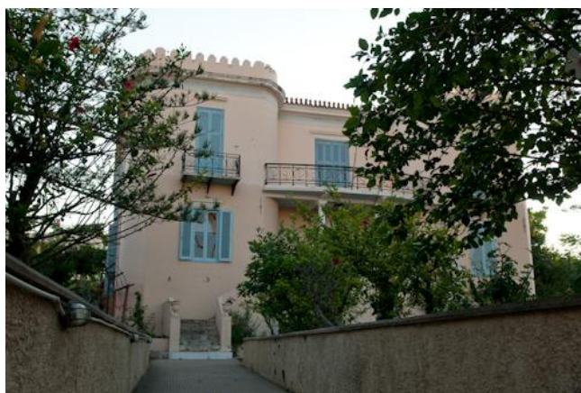
Εικόνα 16. Διατηρητέο κτίριο 23. Πηγή: Ιδία Επεξεργασία
