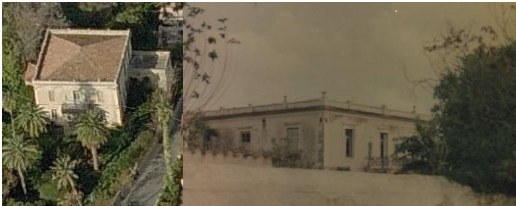
Εικόνα 4. Διατηρητέο κτίριο 8. Πηγή: http://www.bing.com/maps/ (αριστερή εικόνα), http://gis.chania.gr/files/PRESERVABLE/W0069730.jpg (αριστερή εικόνα)
