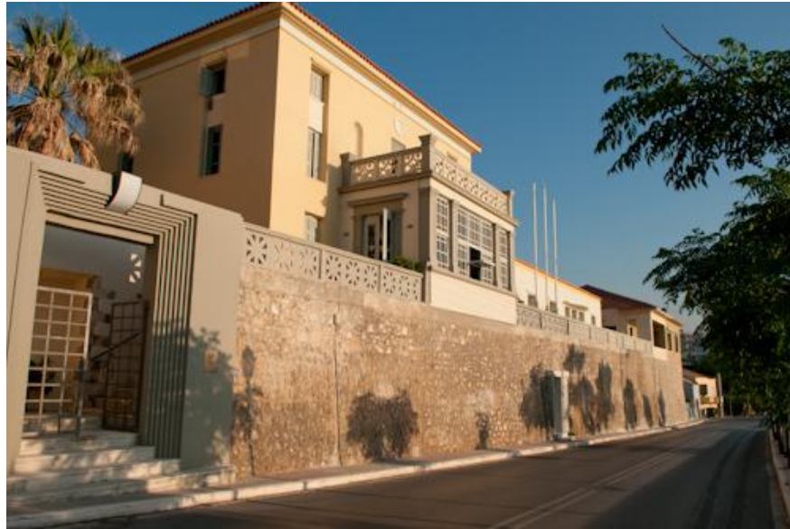
Εικόνα 11. Ξενοδοχείο «Χαλέπα» διατηρητέο κτίριο 15. Πηγή: Ιδία Επεξεργασία
