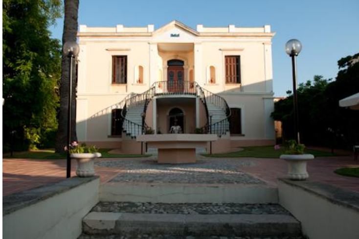
Εικόνα 9. Ξενοδοχείο «Χαλέπα» διατηρητέο κτίριο 13. Πηγή: Ιδία Επεξεργασία
