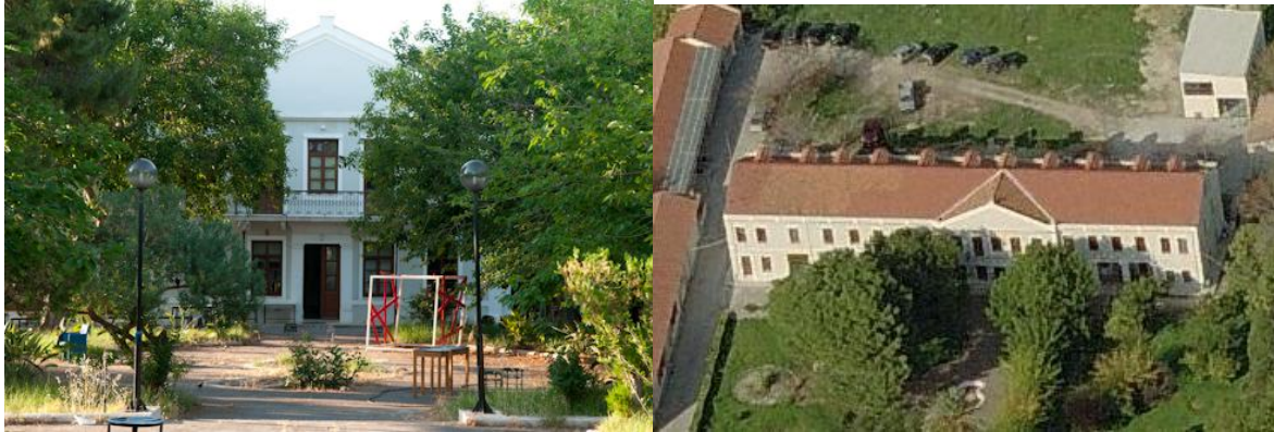
Εικόνα 3. Αρχιτεκτονική Σχολή Πολυτεχνείου Κρήτης, διατηρητέο κτίριο 7. Πηγή: Ιδία Επεξεργασία (αριστερή εικόνα), http://www.bing.com/maps/ (δεξιά εικόνα)
