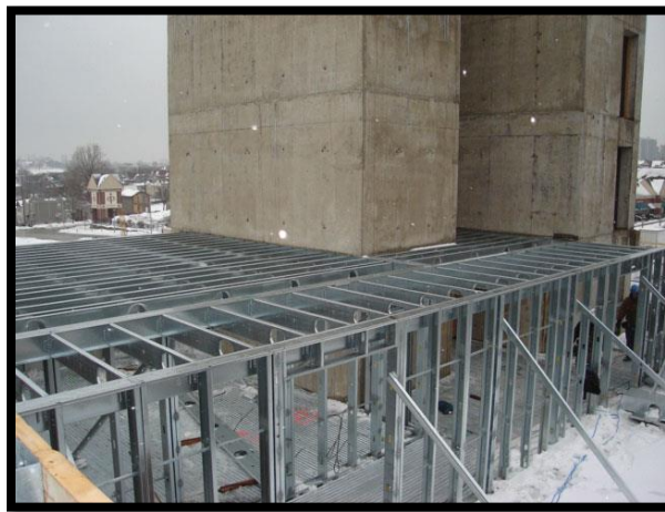
Σχήμα 1.1: Μεταλλικός σκελετός κατοικίας
