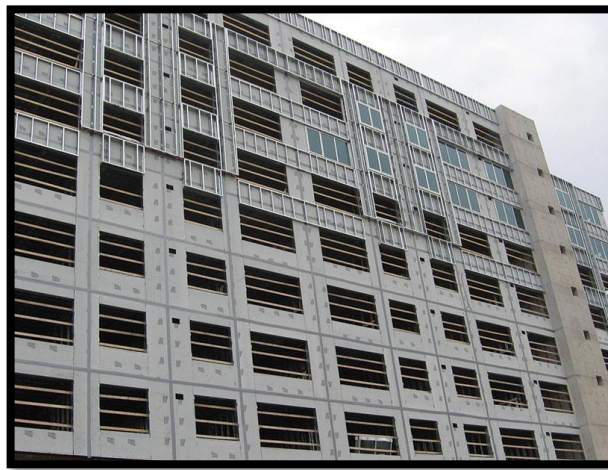
Σχήμα 1.2 : Μεταλλική πρόσοψη κατοικίας
