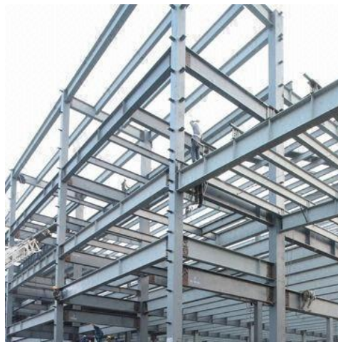
Σχήμα 13α: Μεταλλικός σκελετός κτιρίου
