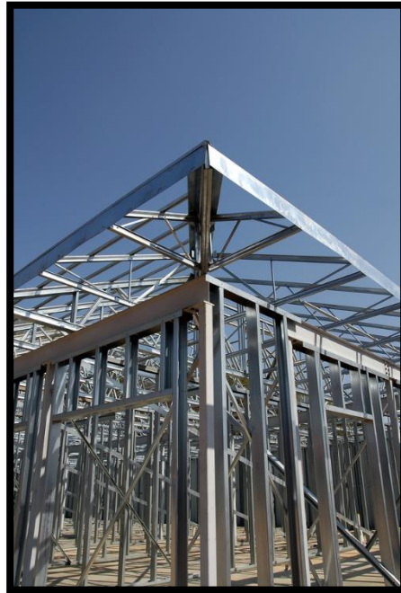
Σχήμα 1.3β: Μεταλλικός σκελετός κτιρίου.
