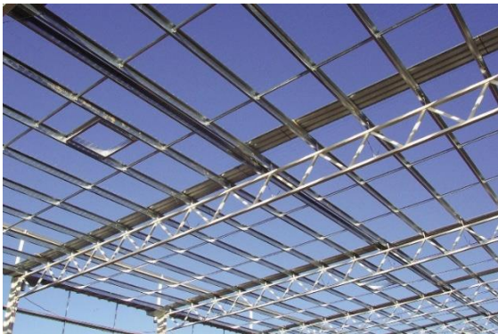
Σχήμα 1.11: Τεγίδες μορφής C & Z
