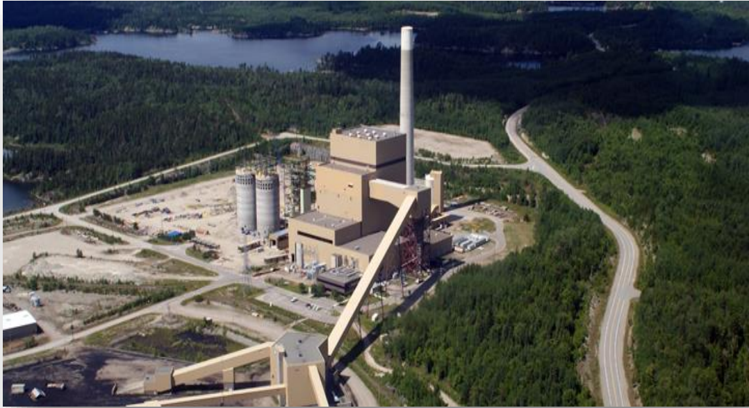
Εικόνα 21. Σταθμός Ηλεκτροπαραγωγής Atikokan, Καναδάς
