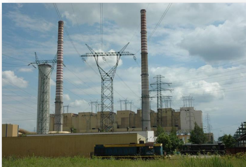
Εικόνα 20. Σταθμός Ηλεκτροπαραγωγής Polaniec, Πολωνία
