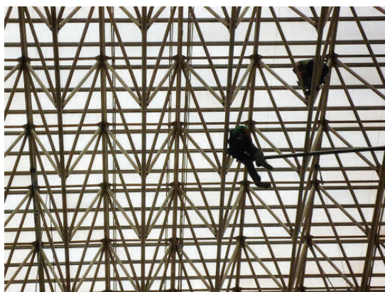
Η κατασκευή του κελύφους.
