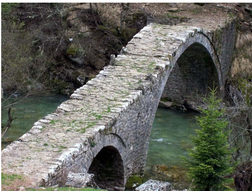
Εικόνα 16: Γεφύρι του Μίχου στην Ανθούσα, (προσωπικό αρχείο)
