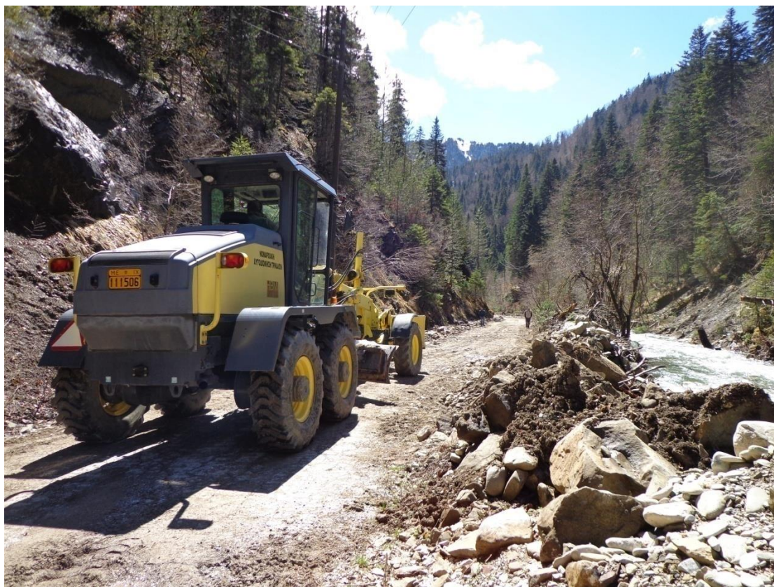
Εικόνα 22: Αναμονή για αποκατάσταση δρόμου, (προσωπικό αρχείο)
