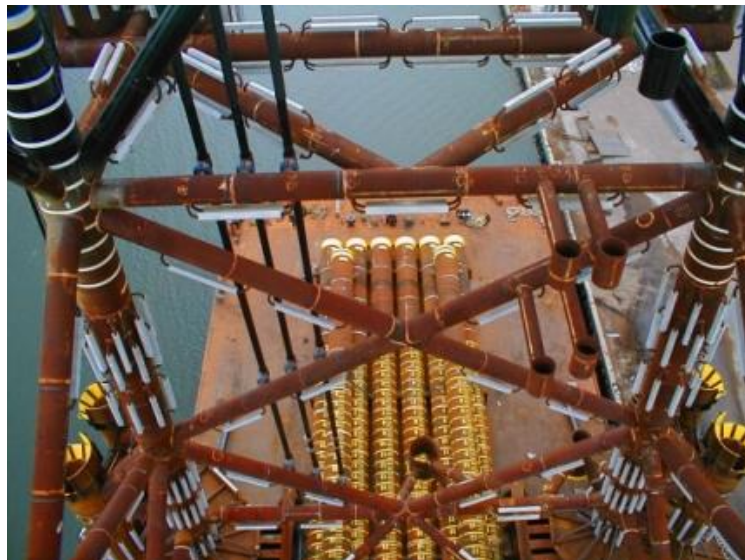
Εικόνα 1.5: Εξέδρα Εξόρυξης Πετρελαίου με προστασία από θυσιαζόμενες ανόδους. (8)
