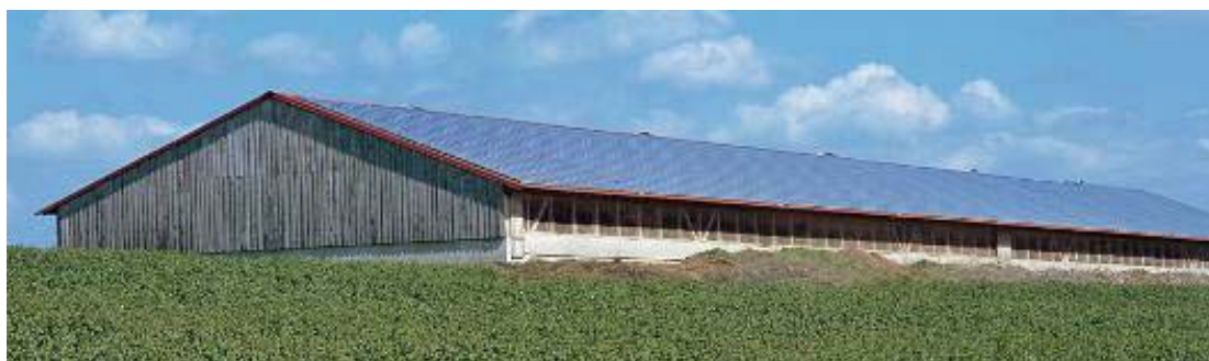
Εικόνα 2.7. Εφαρμογή φωτοβολταϊκών σε αγροτική αποθήκη [10]
