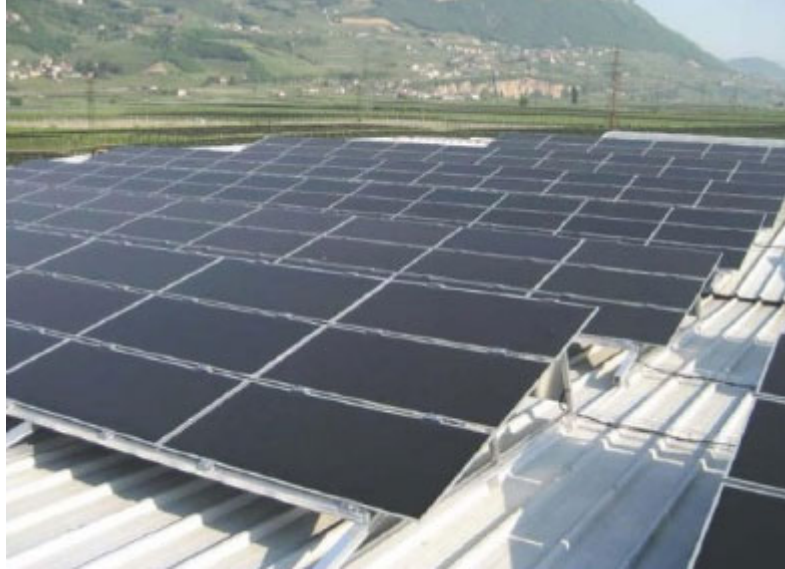
Εικόνα 4.11 βάσεις στήριξης Φ/Β πλαισίων της Schletter [14]
