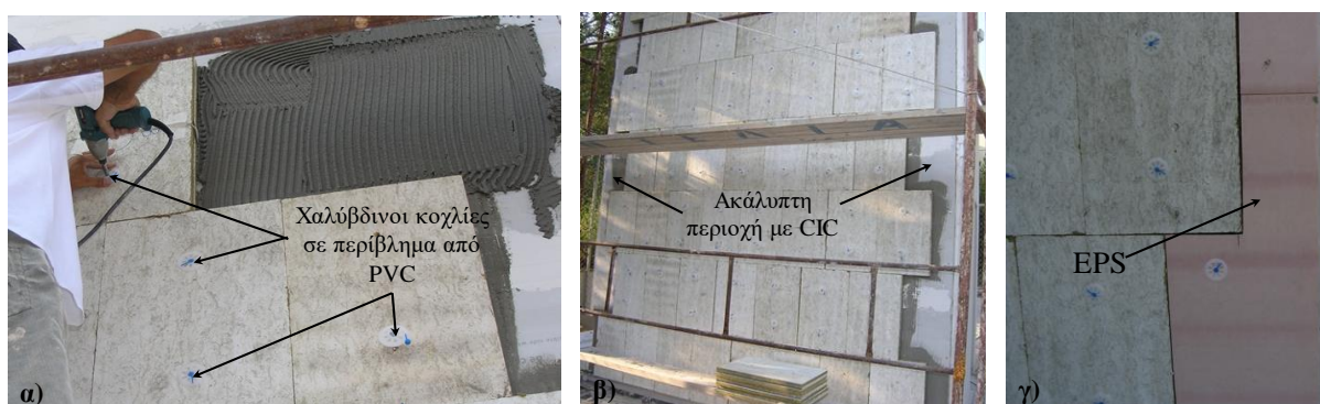
Εικόνα 35 – α) Τοποθέτηση των CIC πάνελ με συγκολλητικό κονίαμα και κοχλίες, β) ακάλυπτη περιοχή από CIC και γ) τοποθέτηση EPS στην ακάλυπτη περιοχή.
