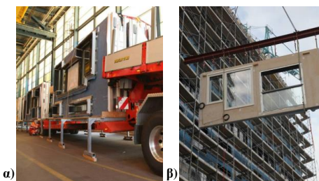
Εικόνα 3 – Προκατασκευασμένη τοιχοποιία: α) μεταφορά και β) τελική τοποθέτηση [27].
