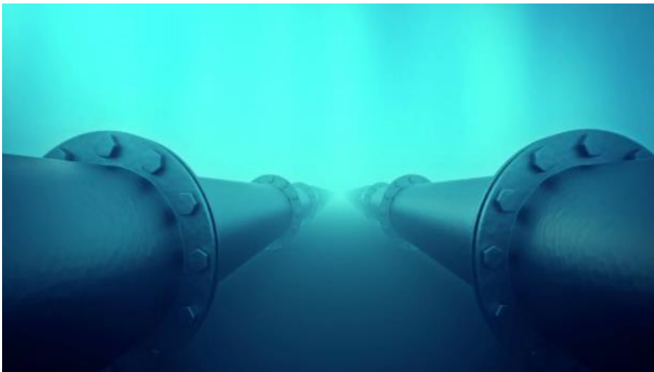
Εικόνα 3.2: Υποθαλάσσιος αγωγός φυσικού αερίου. (Πηγή: www.energypress.gr )
