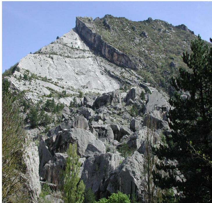
Εικόνα 2.12: Επίπεδη αστοχία πρανούς, Αμερική (Πηγή: www.geotechpedia.com )
