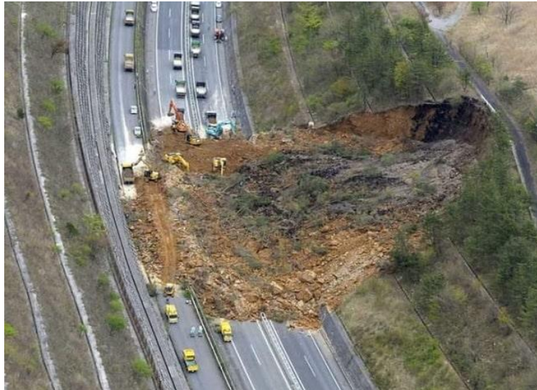
Εικόνα 2.14: Κυκλική αστοχία πρανούς (Πηγή: www.civildigital.com )
