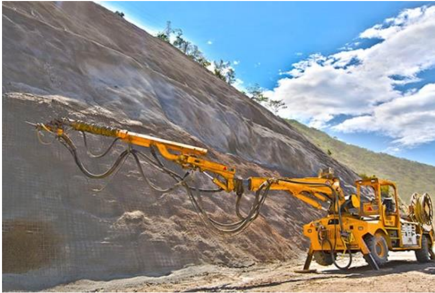
Εικόνα 2.18: Διαδικασία σταθεροποίησης βραχώδους πρανούς με χρήση σπρέι σκυροδέματος (Πηγή: http://bestsupportunderground.com )
