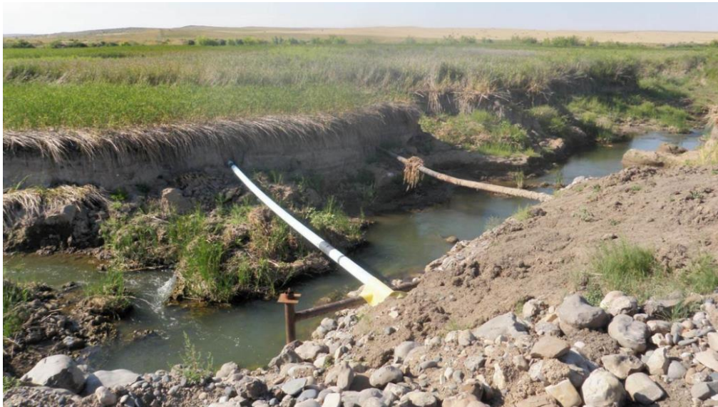
Εικόνα 3.11: Εκτεθειμένοι αγωγοί στον ποταμό Beauvais Creek (Πηγή: www.boycedan.wordpress.com )
