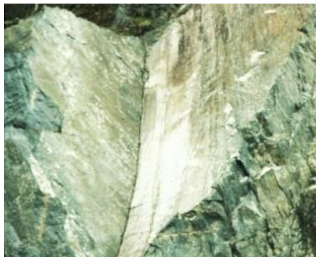
Εικόνα 2.15: Αστοχία σφήνας σε βραχώδες πρανές(Πηγή: www.online.blasttraining.com.au )
