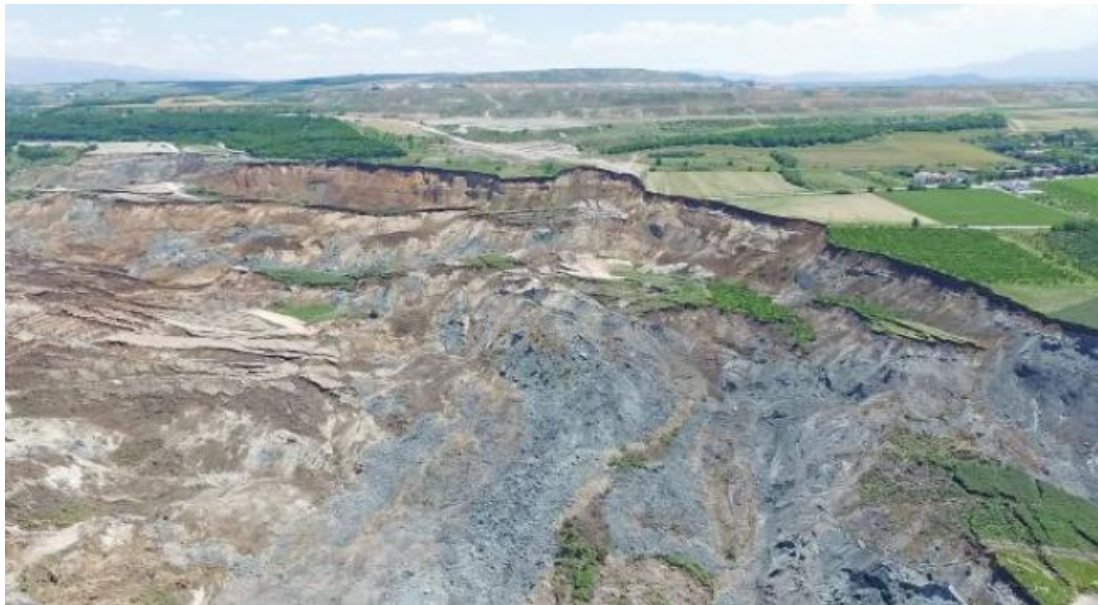
Εικόνα 2.7: Κατολισθήσεις που εκδηλώθηκαν σε λιγνιτωρυχείο της ΔΕΗ στο Αμύνταιο.
