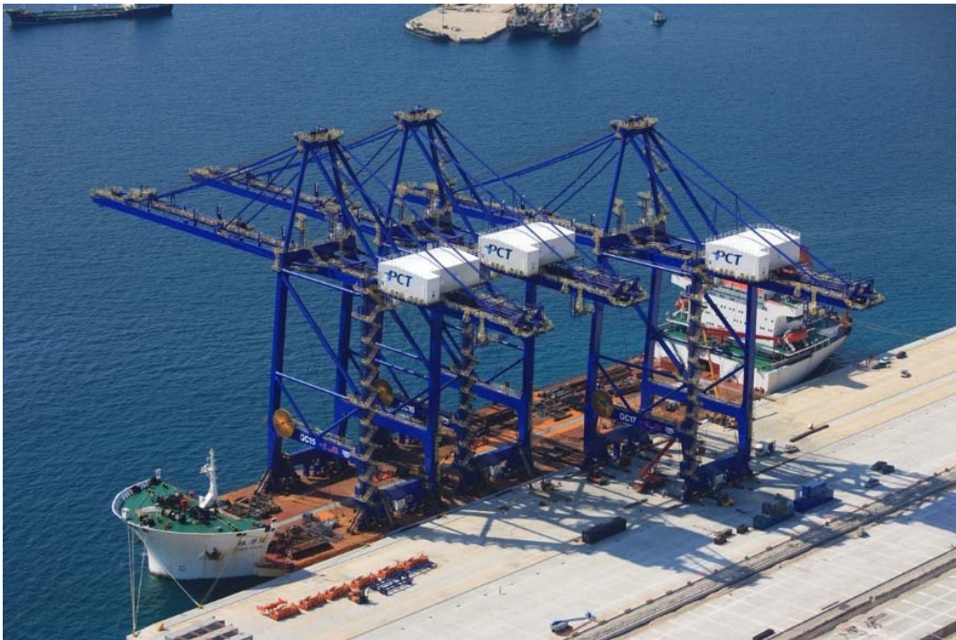
Εικόνα 49: Άποψη λιμενικού εξοπλισμού (Πηγή: Domosferon, 2018)
