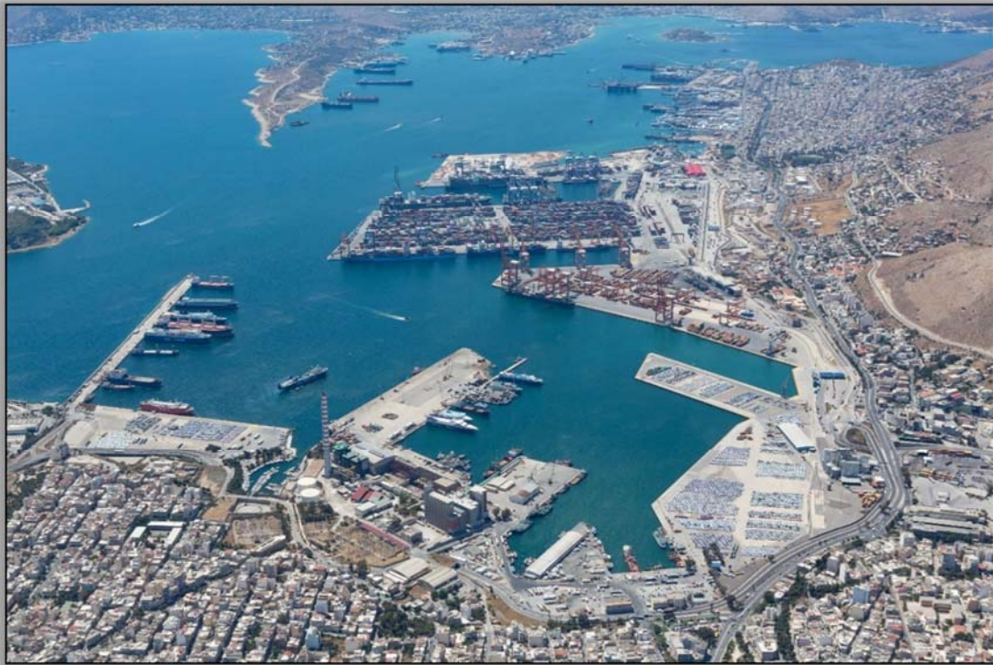
Εικόνα 13: Εμπορικός Λιμένας/ Σταθμός Διακίνησης Αυτοκινήτων & Συμβατικού Φορτίου (Πηγή: Domosferon, 2018)
