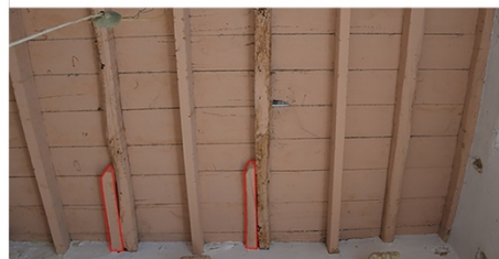
Παράλληλα στοιχία με τα δοκάρια του πατώματος Σύνδεση δοκαριών με ξυλοδεσιές
