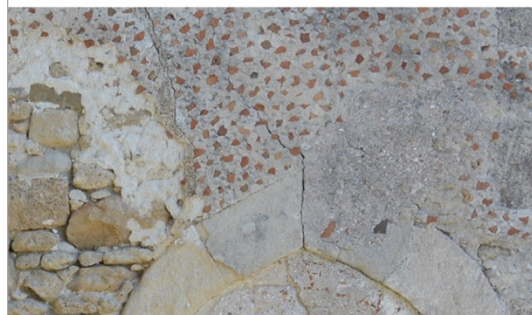
Αρχική μορφή: λαξευμένες πέτρες με εμφανή αρμολόγηση εξωτερικά
