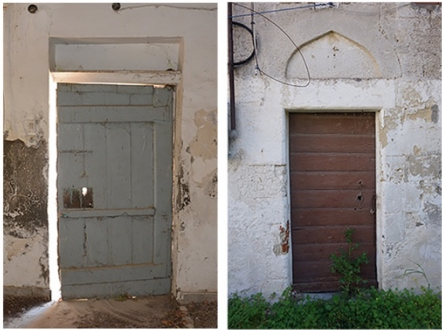
Θύρα εισόδου εσωτερικά
