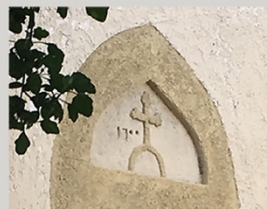
Πύργος Σ. Κινδυλίδη
