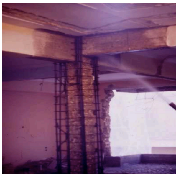
(Εικόνα 6.3) Ενίσχυση υποστυλώματος με μανδύα οπλισμένου σκυροδέματος
