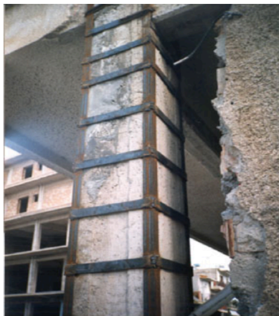
(Εικόνα 6.2) Επέμβαση με μεταλλικό κλωβό
