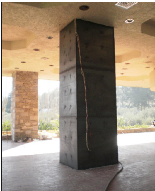
(Εικόνα 6.1) Περίσφιξη με ολόσωμο μανδύα από FRP
