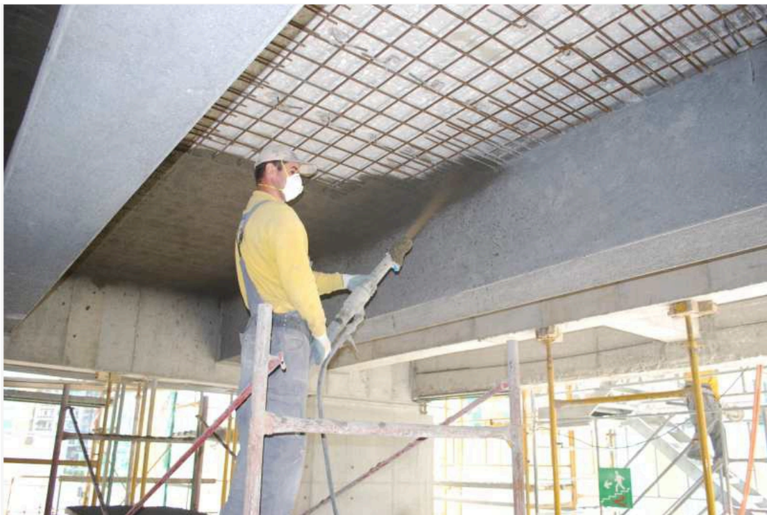
(εικόνα 4: εφαρμογή εκτοξευόμενου σκυροδέματος - gunite)
