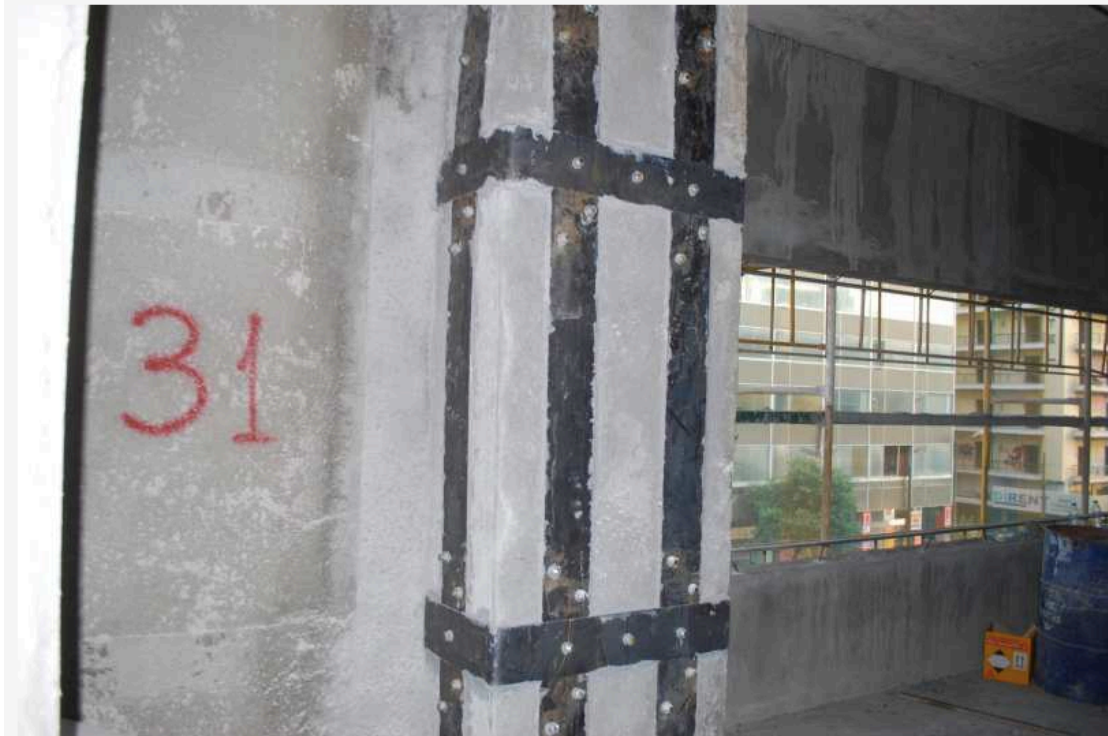
(εικόνα 3: ενίσχυση υποστηλώματος με μεταλλικές λάμες)
