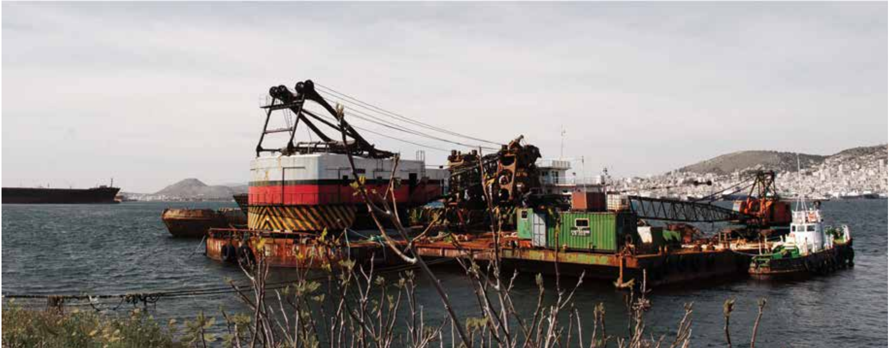
Μια πλατφόρμα επισκευής σε κοντινή απόσταση από την χερσόνησο, εκεί που βρίσκονται τα πέτρινα κτήρια.
