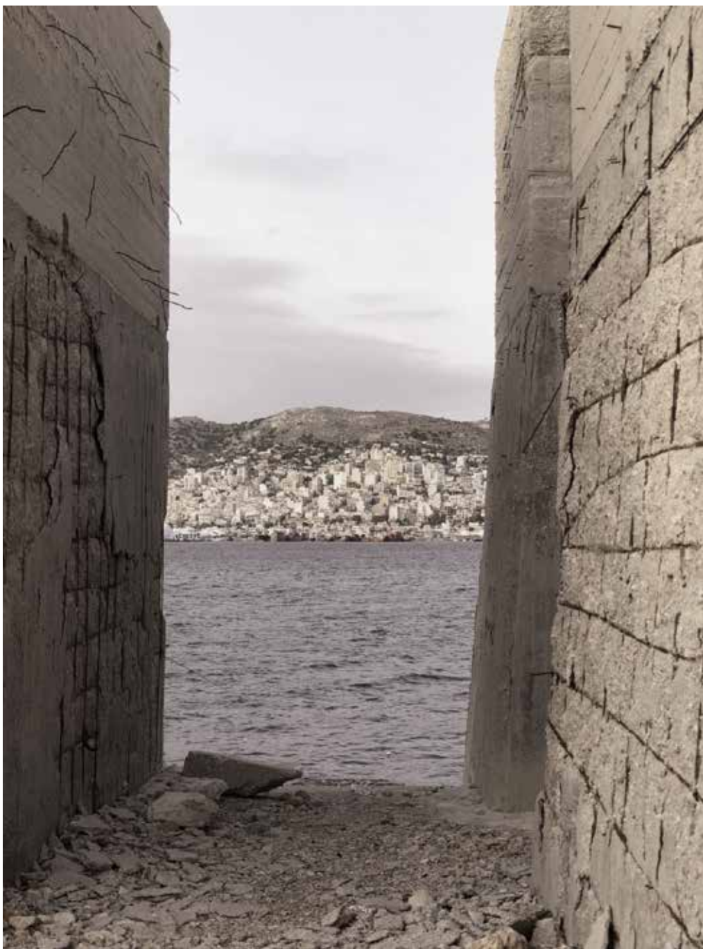
Φυγή προς την πόλη του Περάματος, ανάμεσα στους μπετονένιους τοίχους που έχει τοποθετήσει ο ΟΛΠ.
