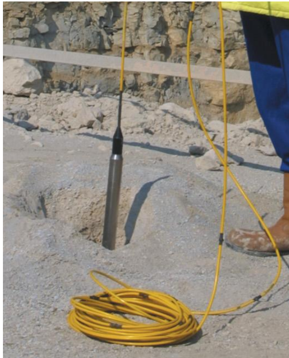
Εικόνα 7.7 – Κάθοδος του αισθητήρα μέσα στο διάτρημα
