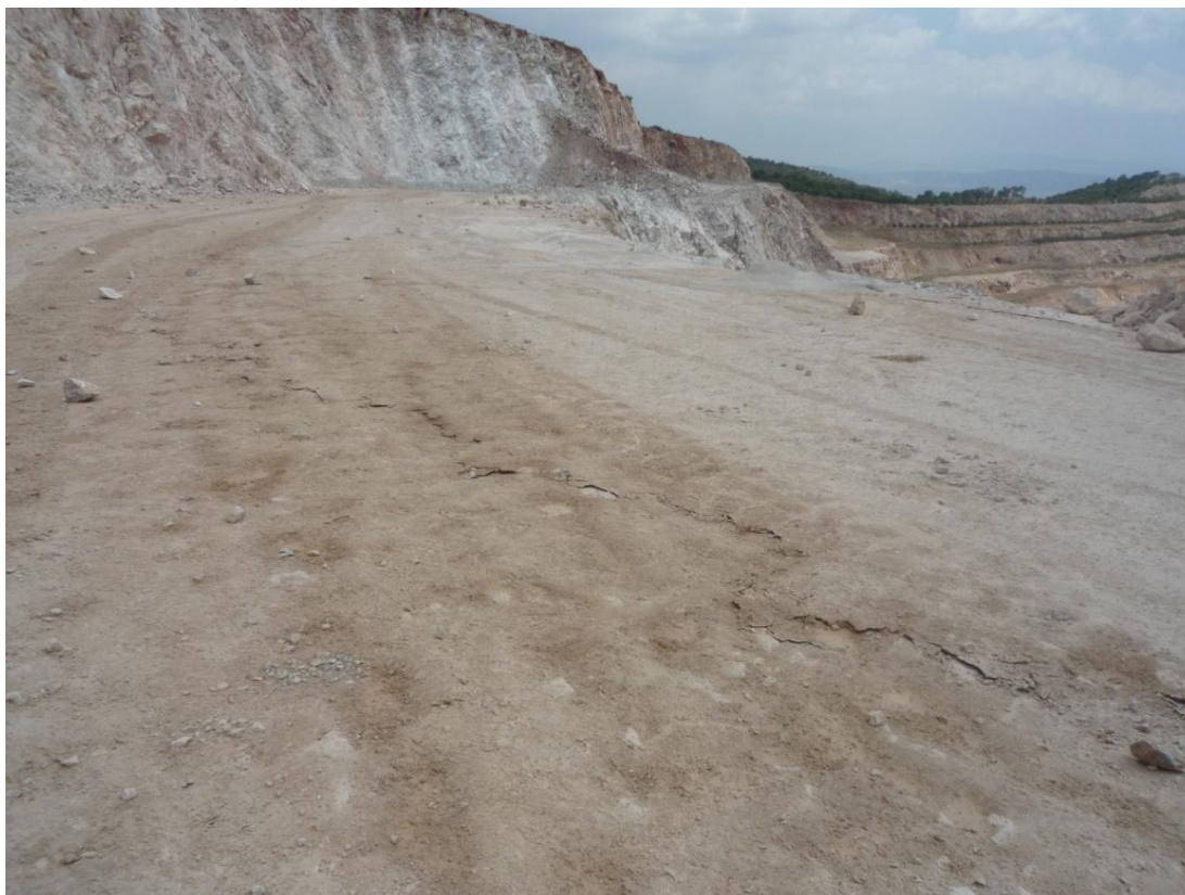
Εικόνα 7.15 – Υπερεκσκαφή στη βαθμίδα μετά την ανατίναξη
