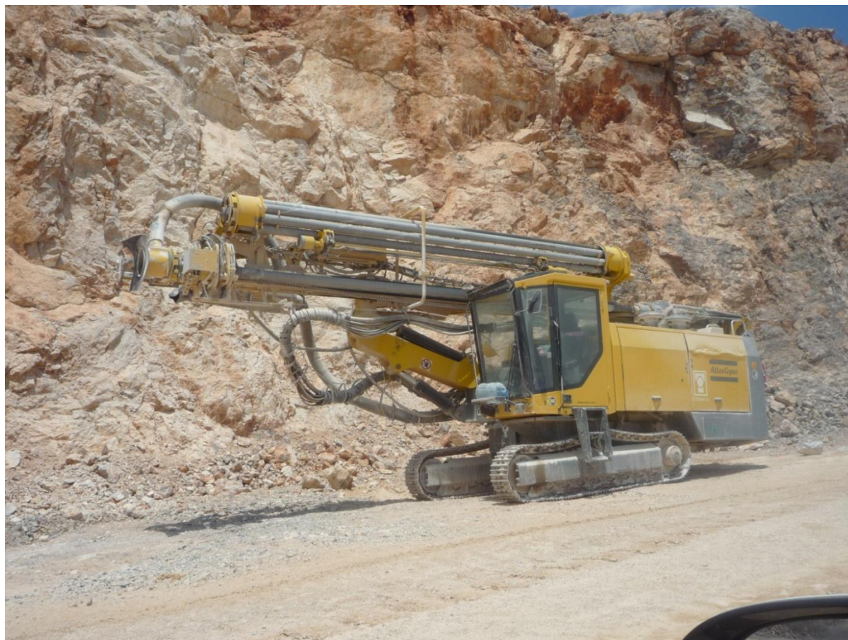
Εικόνα 7.6 - Atlas Copco, Roc L8 Down the Hole drill Irig – Ενδοδιατρηματική Σφύρα στο Λατομείο Χάλυψ
