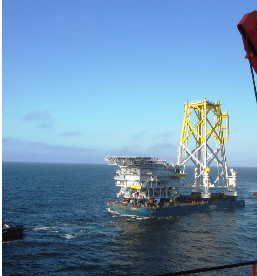
Εικόνα 9.1: Μεταφορά κατώτερου και ανώτερου τμήματος υποσταθμού με φορτηγίδα (Πηγή: ISC Consulting Engineers A/S).
