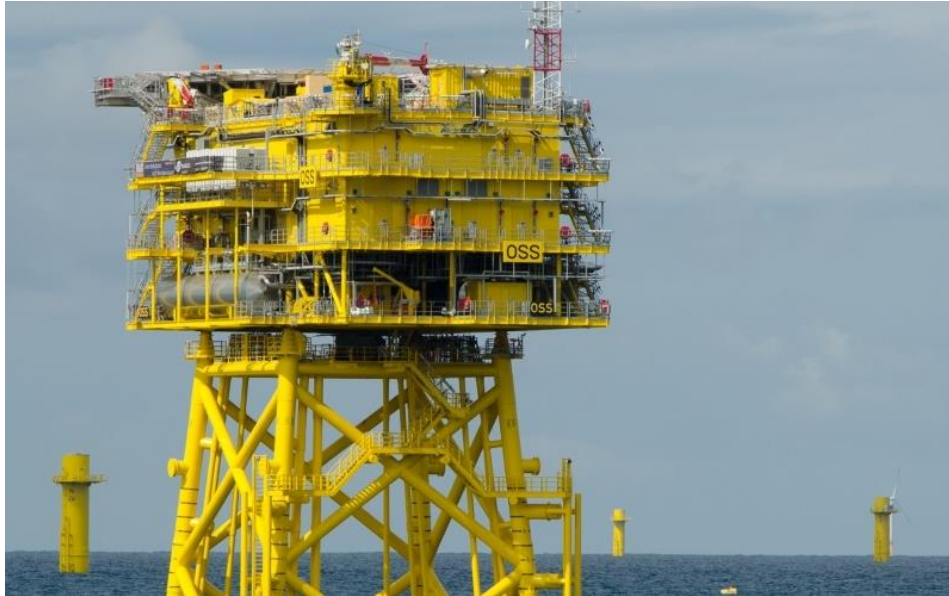
Εικόνα 1.2: Θαλάσσιος ηλεκτρικός υποσταθμός με κατασκευή έδρασης τύπου jacket. (Πηγή: Nordsee One GmbH)
