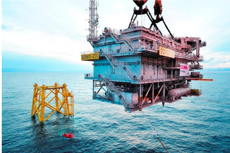
Εικόνα 9.2: Ανάρτηση και ανύψωση ανώτερου τμήματος κατασκευής για τοποθέτηση (Πηγή: ISC Consulting Engineers A/S).
