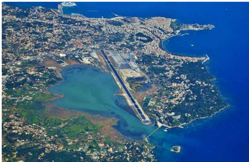
Εικόνα 14: Διεθνής Αερολιμένας Κέρκυρας
