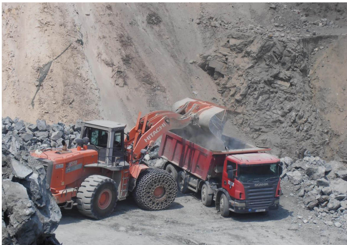
Εικόνα 4.3. Φόρτωση και μεταφορά υλικού στην σκυροθραυστική μονάδα.
