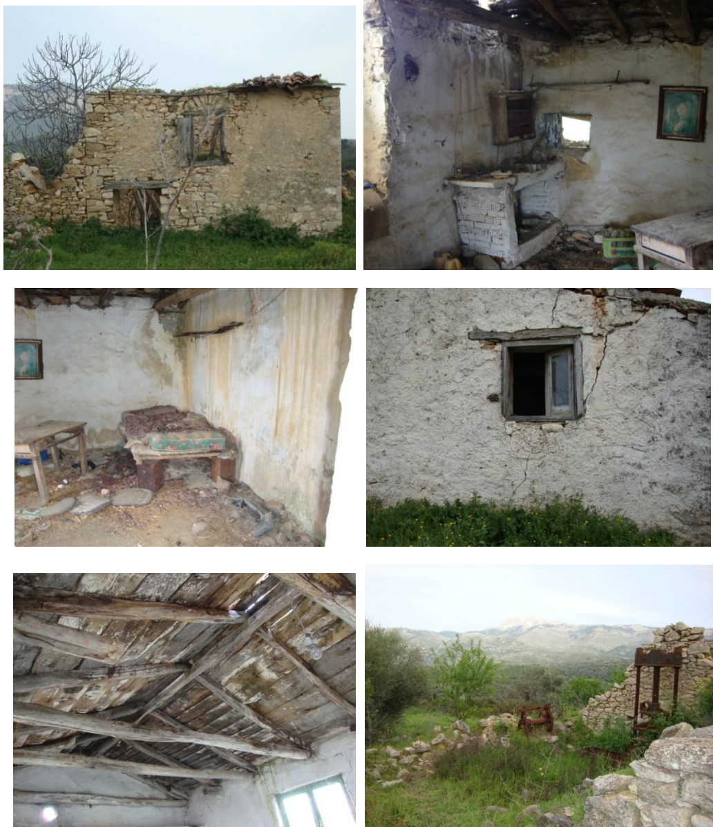
Εικόνα 4.9: Από πάνω και δεξιόστροφα: (α) Εγκαταλελειμμένο σπίτι στο χωριό Σκουντέρι όπου φαίνονται η πόρτα και το παράθυρο. Στο πάνω μέρος του παραθύρου διακρίνεται ο κάθετος προσανατολισμός της πέτρας για διακόσμηση (β) Εσωτερικό εγκαταλελειμμένου σπιτιού με προσωπικά υπάρχοντα (γ) Παράθυρο εγκαταλελειμμένου σπιτιού χωρίς την λεπτομέρεια διακόσμησης (δ) Εσωτερικό του ίδιου εγκαταλελειμμένου σπιτιού (ε) Η αρχιτεκτονική της στέγης (στ) Εναπομείναντα εργαλεία λιοτριβίου στο χωριό
