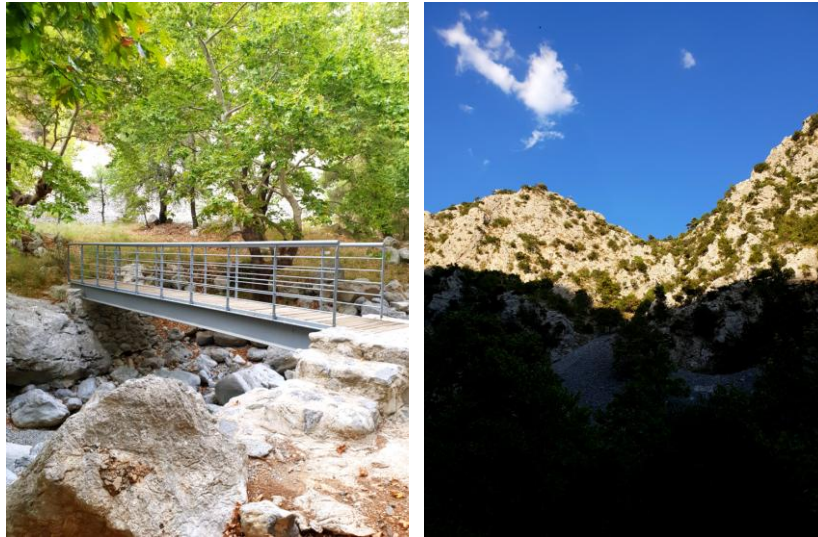
Εικόνα 7.7: Από πάνω και δεξιόστροφα: (α) Η κατολίσθηση κρύβει το μονοπάτι με πέτρες (β) Το ξύλινο παγκάκι στη πηγή «Κρυόβρυση» το οποίο είναι κατεστραμμένο (γ) Η πηγή «Κρυόβρυση» (δ) Το δέντρο εισχωρεί στον βράχο και με τις ρίζες του τον «σπρώχνει» (ε) Το σιδερένιο γεφύρι (ε) Όταν η σκιά αγκαλιάζει το φαράγγι
