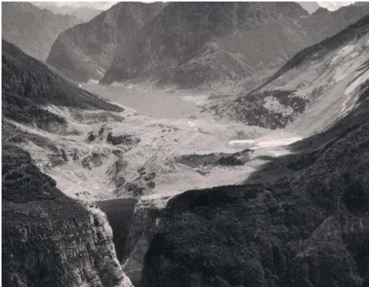
Εικόνα 2: Απεικόνιση κατολίσθησης στον ταμιευτήρα του φράγματος Vajont (British Dam Society)
