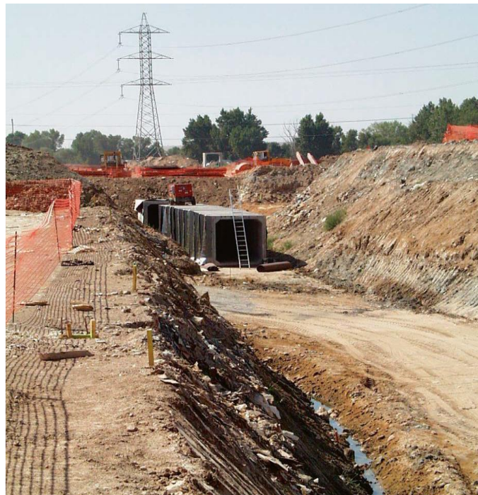
Εικόνα 11. Εγκατάσταση σήραγγας σε περιοχή της κεντρικής Ευρώπης (NationalGrid, 2015)
