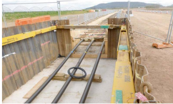
Εικόνα 7. Άμεση εγκατάσταση καλωδίων σε μια αγροτική περιοχή (NationalGrid, 2015)
