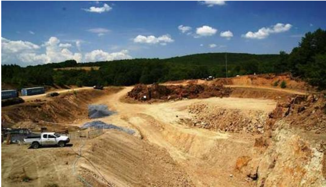
Εικόνα 15. Κατασκευή φράγματος πάνω σε ενεργό σεισμικό ρήγμα στις Σκουριές, (Παπαζάχος 2016)
