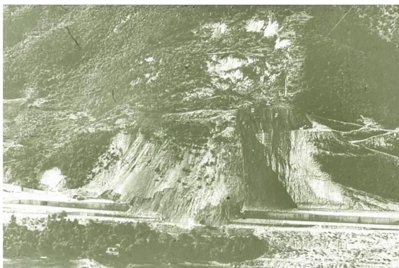
Εικόνα 60. Η μεγάλη κατολίσθηση της Παναγοπούλας το 1971 τύπος περιστροφική ολίσθηση εδάφους σε εναλλαγές ασβεστολίθων – σχιστολίθων, (Κυρακύκλας, 2009)
